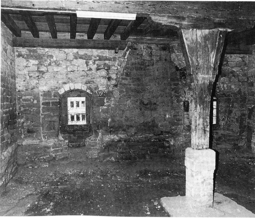
Fig. 130 Romont/Château. Le mur nord de la salle 002, avec les vestiges de la cheminée, encadrée d'archères transformées en fenêtres à la fin de l'époque gothique. Le pilier date des années 1538/40
