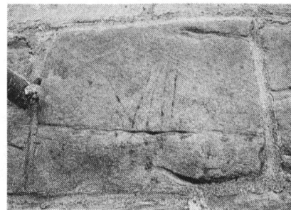
Fig. 91 Fribourg/Gottéron. Détail d'une marque de hauteur d'assise sur le parement côté ville
