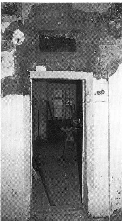
Fig. 53 Fribourg/Petit-St-Jean 35-37. N° 37, la porte à fenêtre oblongue du rez-de-chaussée
