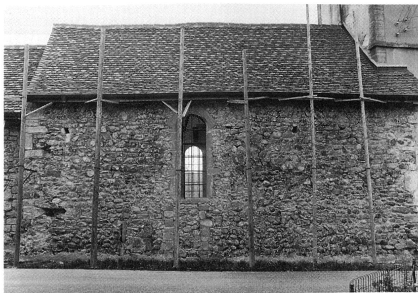
Fig. 120 Montbrelloz/St-Jean-Baptiste. Le mur nord de la nef montre les traces d'une porte, d'une armoire et des solivages d'un bâtiment qui y était accolé. Ce bâtiment a été démoli au plus tard au XVIII e siècle
