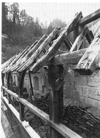
Fig. 92 Fribourg/Gottéron. La charpente de 1441/42 côté ville, état durant les travaux en décembre 1994
