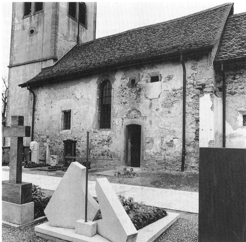
Fig. 118 Montbrelloz/St-Jean-Baptiste. Mur sud de la nef de la fin du XIII e ou du XIV e siècle, avec sa porte à arc trilobé, transformée au XVIII e -XIX e siècle, et les traces d'un contrefort à l'angle
