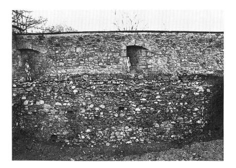
de 56 centimètres, il est constitué de petits moellons de calcaire liés par un mortier beige, grenu.
