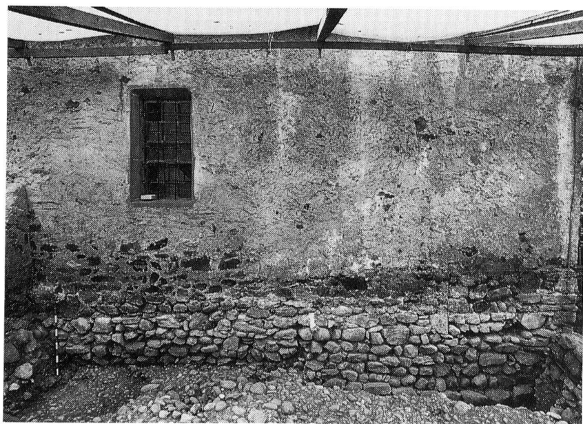
Fig. 143 Treyvaux/St-Pierre et St-Paul. Mur nord de la nef reconstruit, vers 1428 probablement, sur des fondations antérieures. À gauche, les fondations de la nef romane, à droite, celles de l'al- longement
