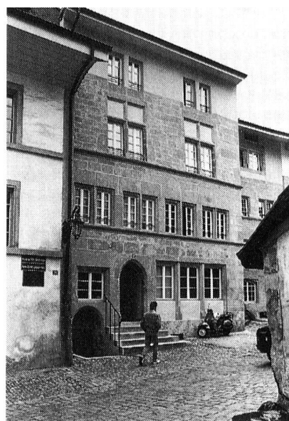
Fig. 47 Fribourg/Petit-St-Jean 35-37. N° 37, la façade sur rue après restauration
