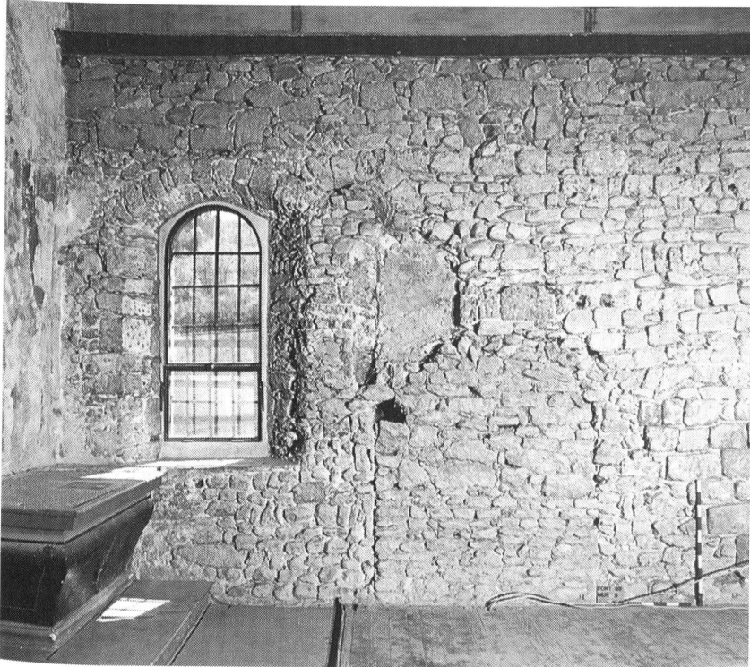
Fig. 27 Font/St-Sulpice. Mur sud de la nef, avec les vestiges d'une fenêtre romane coupée par une baie postérieure, le négatif d'une dalle et une niche de confessionnal
