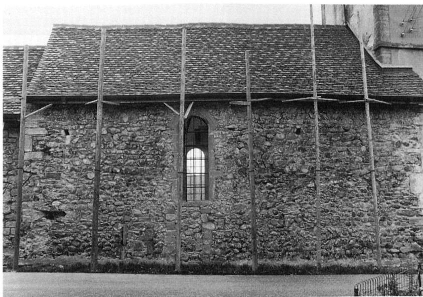
Fig. 120 Montbrelloz/St-Jean-Baptiste. Le mur nord de la nef montre les traces d'une porte, d'une armoire et des solivages d'un bâtiment qui y était accolé. Ce bâtiment a été démolit au plus tard au XVIII e siècle
