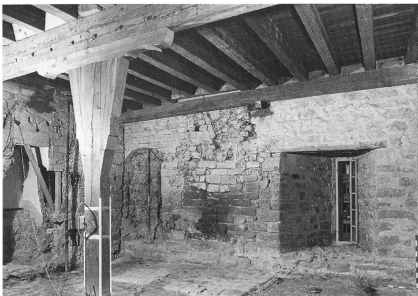
Fig. 132 Romont/Château. Vue de la salle 001; les vestiges des deux cheminées successives et de l'armoire occidentale sont bien visibles. L'archère de droite date de 1437 environ, l'autre de la 2 e moitié du XV e siècle. Le pilier de bois est une restitution moderne
