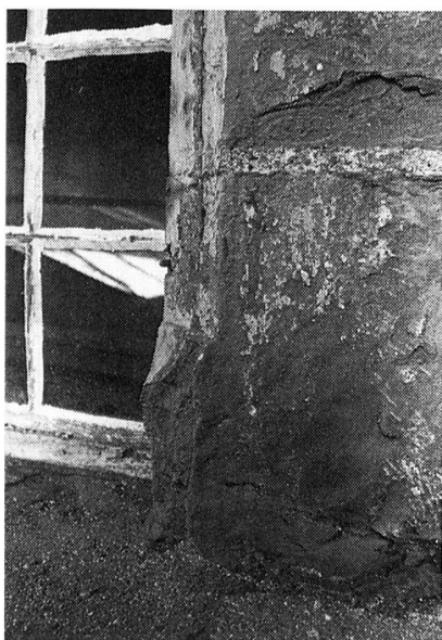
Fig. 45 Fribourg/Petit-St-Jean 35-37. N° 37, un congé des fenêtres du deuxième étage de la façade ouest (la feuillure est postérieure)
