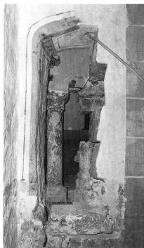
Fig. 31 (en bas) Font/St-Sulpice. Ancienne porte nord de la nef, établie en 1560 en remplacement d'une entrée antérieure dont un piédroit est visible sur la droite
