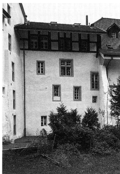
Fig. 46 Fribourg/Petit-St-Jean 35-37. N° 37, la façade sud après restauration
