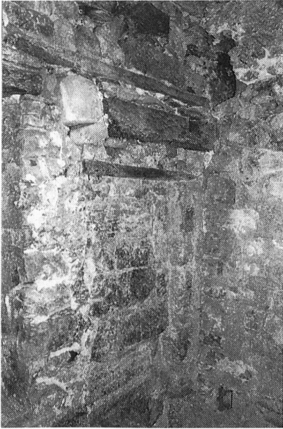
Fig. 62 Fribourg/Epouses 16. Les vestiges de la porte d'accès au rez-de-chaussée (deuxième phase)
