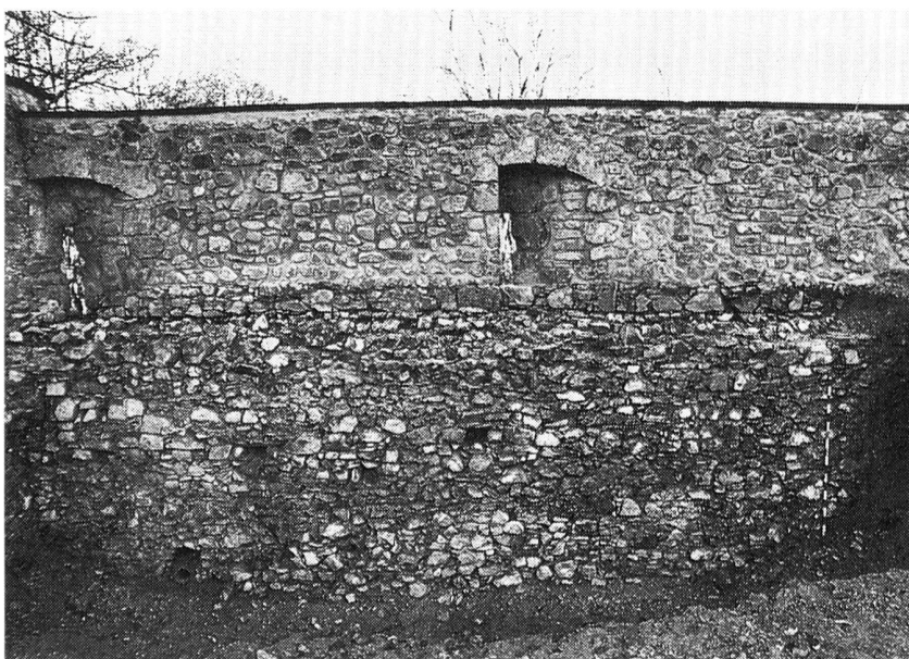
Fig. 107 Gruyères/Château. Vue du parement est de la courtine occidentale avec ses fondations dégagées par l'excavation
