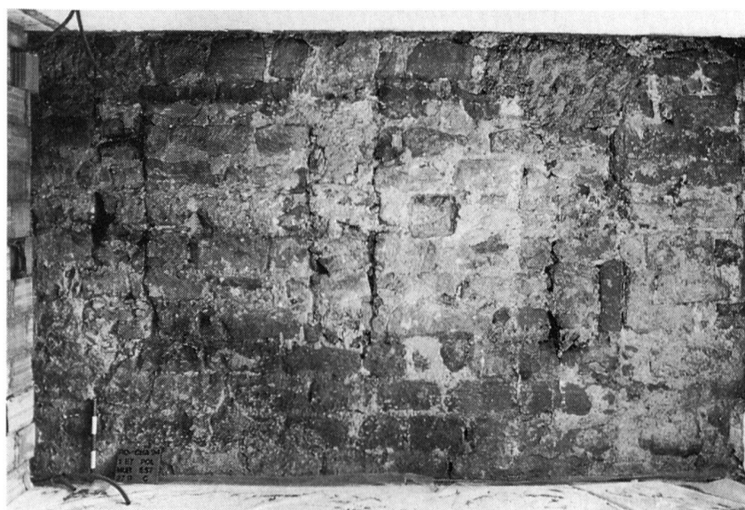
Fig. 137 Romont/Château. Baies gothiques ménagées au premier étage de l'aile nord, dans la façade occidentale
