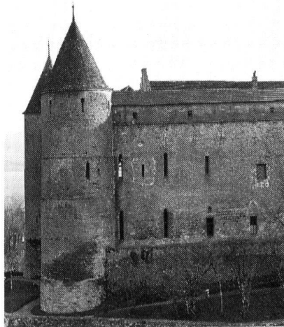
Fig. 18 Estavayer-le-Lac/Château de Chênaux. Château de Grandson, secteur oriental de la grande courtine nord, 1277-1279. A remarquer: les baies-lancettes ajourant la courtine et les plateaux de chêne renforçant la maçonnerie de la tour (Photo Claude Bornand, Lausanne)
