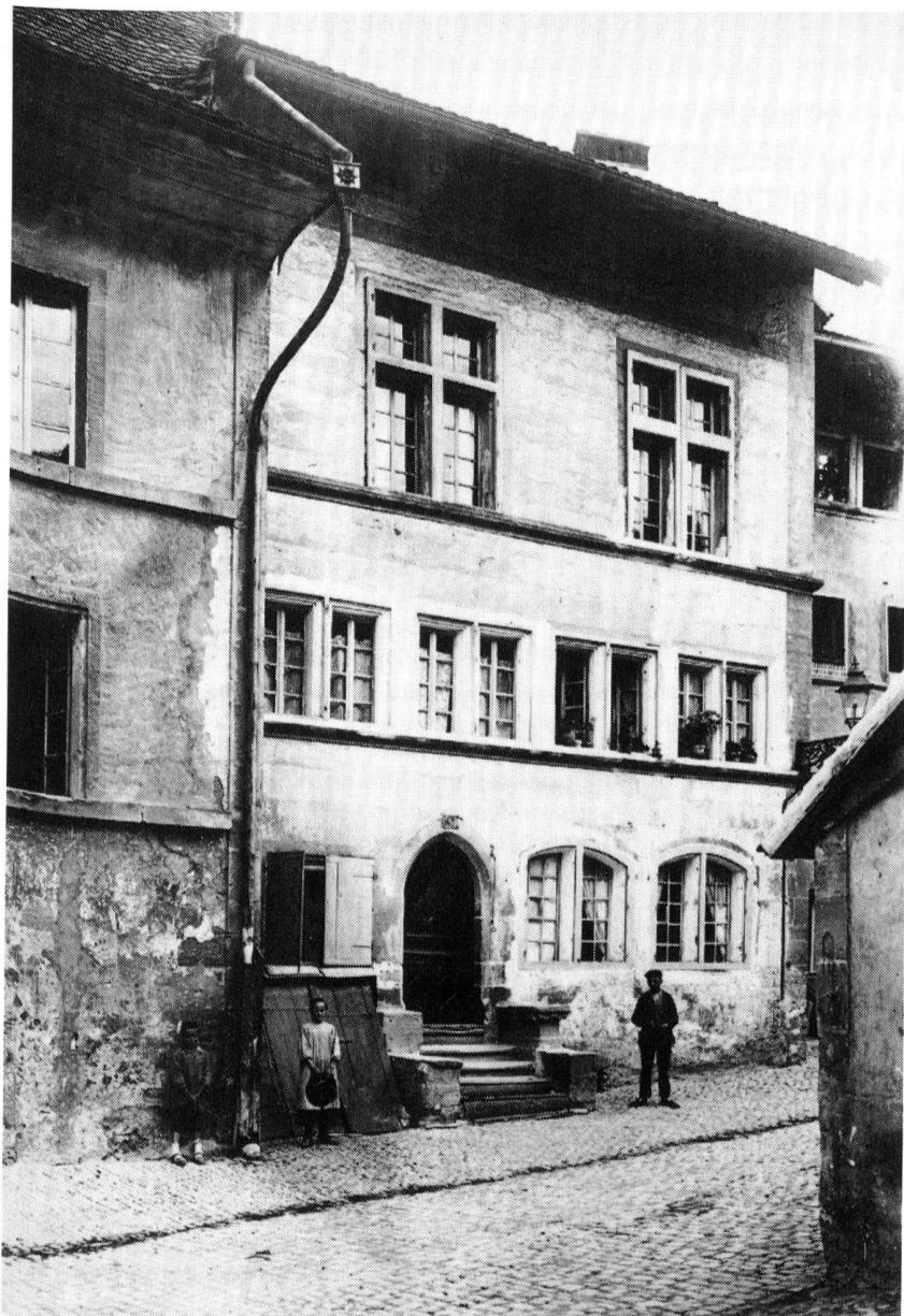
Fig. 42 Fribourg/Petit-St-Jean 35-37. N° 37, la façade nord vers 1900 (cliché du fond Reiners)
