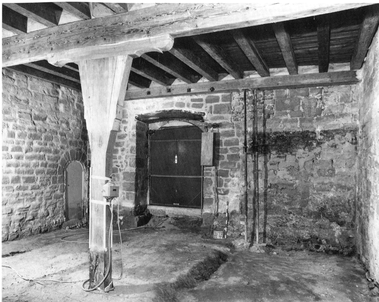
Fig. 135 Romont/Château. Extrémité sud de la salle 001. Les traces des deux petites fenêtres hautes du XIII e siècle sont visibles de part et d'autre de la porte de 1542 environ
