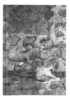
Fig. 66 Fribourg/Epouses 16. Les traces de lierre sur le parement occidental du mur de refend (troisième phase)
