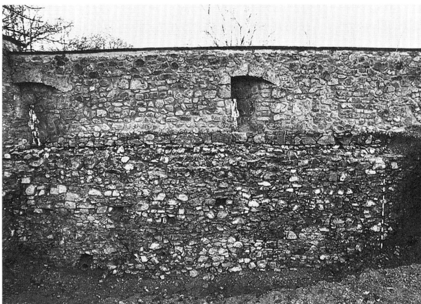
Fig. 107 Gruyères/Château. Vue du parement est de la courtine occidentale avec ses fondations dégagées par l'excavation
