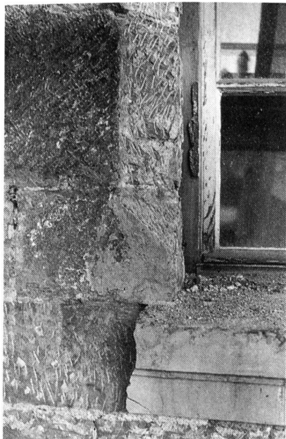
Fig. 39 Fribourg/Petit-St-Jean 35-37. N° 35, détail des moulures du deuxième étage de la façade sur rue, après l'enlèvement du ciment
