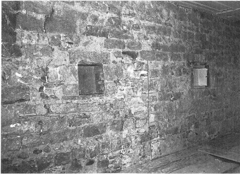
Fig. 71 Fribourg/Epouses 16. Le mur mitoyen nord et ses deux niches, au premier étage (cinquième phase)
