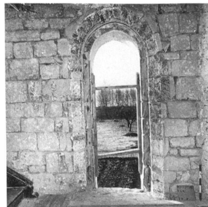
Fig. 19 Fenêtre du mur sud de la nef; les blocs de son encadrement ont été calés par les maçons à l'aide de coins de bois taillés dans des arbres abattus, d'après la dendrochronologie, en automne-hiver 1345-1346. Traces des décors peints des XIV e et XVI e siècles
