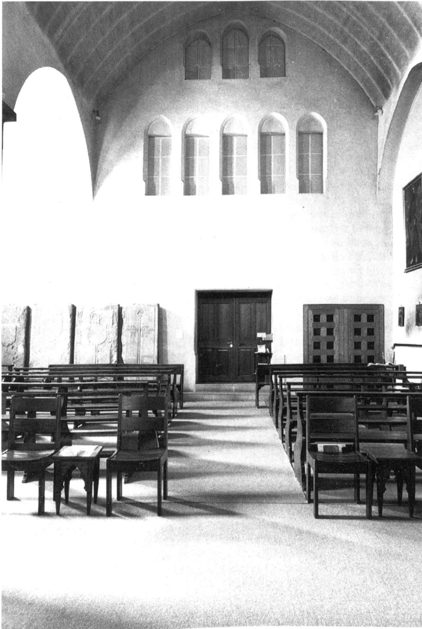
Fig. 83 Le mur de refend construit en 1873 entre la nef et l'hôtellerie, état vers 1990, après l'abaissement de la voûte et la suppression de deux fenêtres en 1908 et l'enlèvement du décor néogothique de la porte vers 1965. Comparer avec le dessin du Père Hartmann (fig. 81) (Photo: N. Repond, Bulle)
