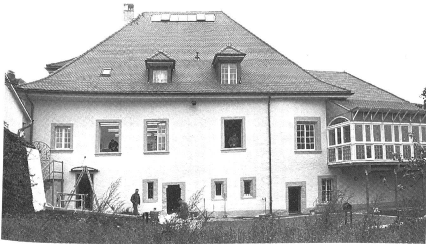
Fig. 47 Estavayer-le-Lac/Maison Griset de Forel. Vue générale de la maison du nord-ouest, à la fin des travaux
