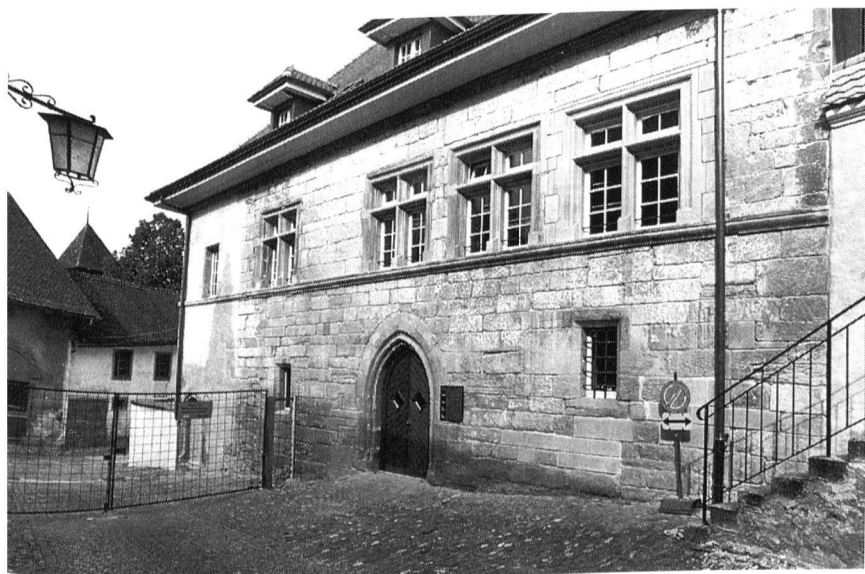
Fig. 34 Estavayer-le-Lac/Maison Griset de Forel. La façade SE après restauration des encadrements
