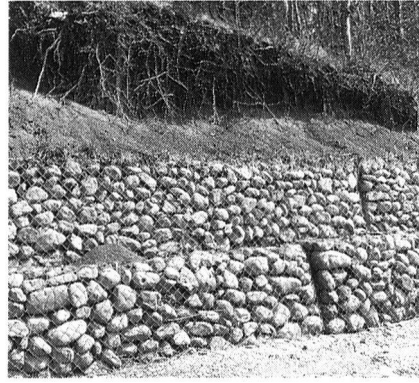
Abb. 13 Düdingen/Schiffenengraben. Ufersicherung mit Steinkörben, die von der Gemeinde Düdingen in den 70er Jahren auf der Nordwestseite der Landzunge angelegt wurde
