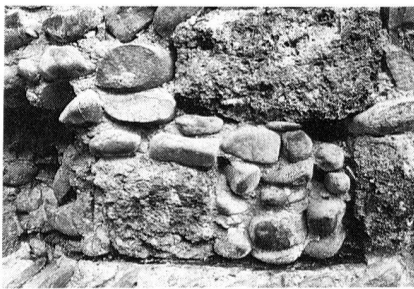
Fig. 81 Fribourg/Samaritaine 19-21. Mur SE, fenêtre de la première phase
