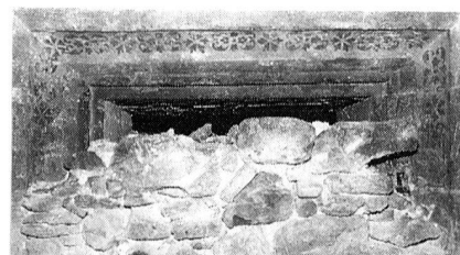
Fig. 46 (tout en bas) Estavayer-le-Lac/Maison Griset de Forel. Bâtiment principal, premier, local NW, détail du décor peint du plafond
