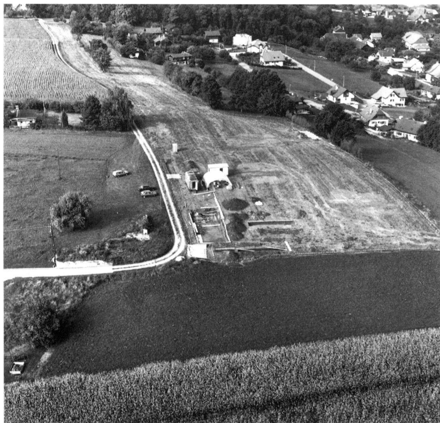
Fig. 6 Châtillon/La Vuarda. Vue générale du chantier (nord-sud)
