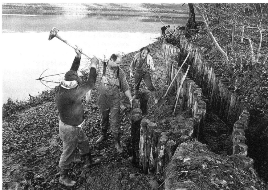
Abb. 14 Düringen/Schiffenengraben. Arbeiten an der Nordspitze der Landzunge bei besonders niedrigem Wasserstand (November 1993). Eng nebeneinander eingeschlagene Lärchenpfähle schützen die Fundstätte auf einer Länge von 35 m
