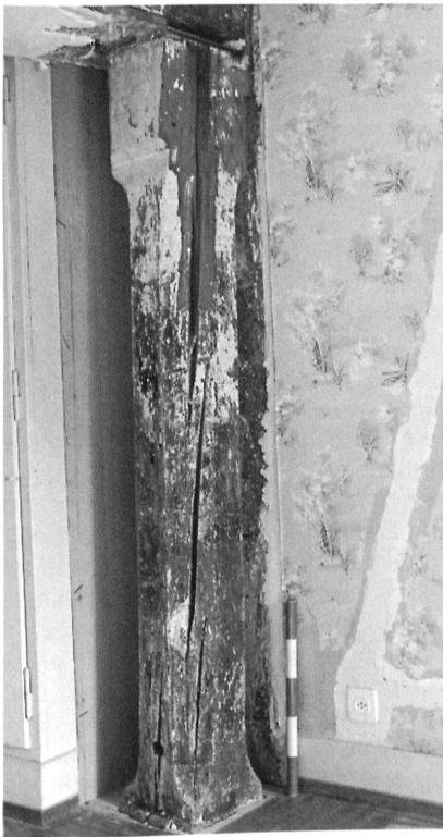
Fig. 131 Fribourg / Pl. Notre-Dame 14–16. Un des poteaux de chêne de 1475
