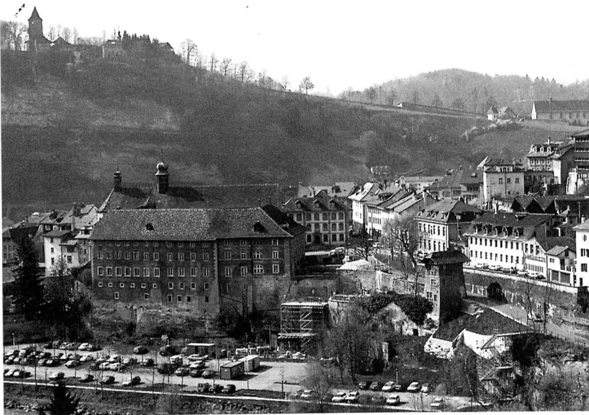
Fig. 54 Fribourg / Pl. des Augustins. Vue générale du nord-est: le couvent des Augustins, la place des Augustins et le chemin des Archives
