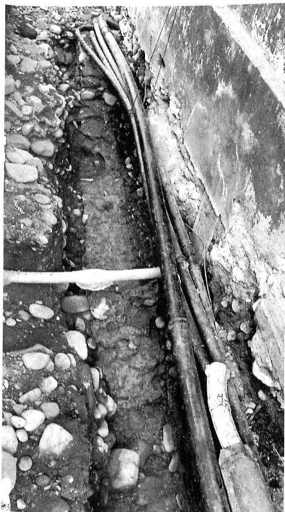
Fig. 64 Fribourg / Pl. des Augustins. Le mur nord du bâtiment 3
