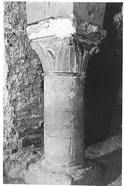
Fig. 112 Fribourg / Samaritaine 19. Vue d'ensemble de la colonne
