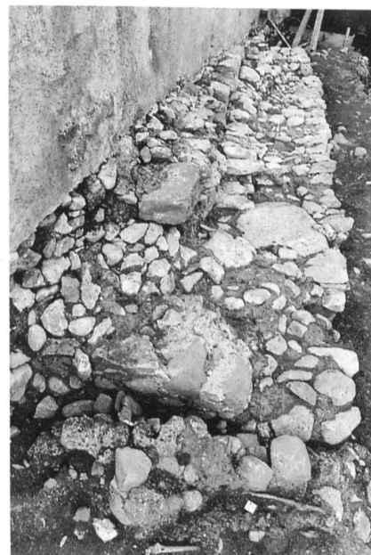
Fig. 242 Villaz-St-Pierre / La Villaire. Fondations de l'ancienne église
