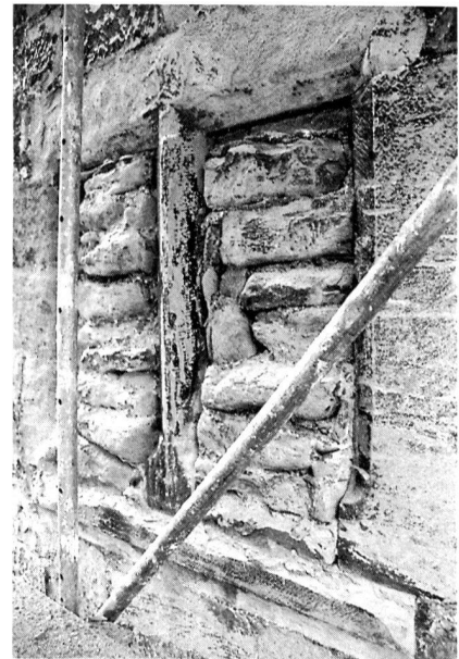
Fig. 100 Fribourg / Pt-St-Jean 29. Détail d'une fenêtre du XIV e siècle
