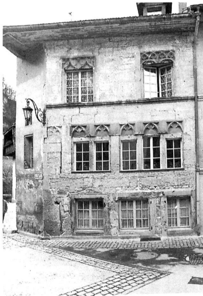
Fig. 98 Fribourg / Pt-St-Jean 13. Façade côté place
