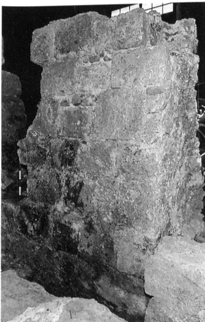
Fig. 132 Fribourg / Pl. Notre-Dame 14–16. Le mur de soutènement, vers 1500
