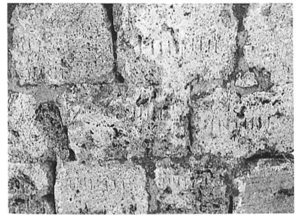
Fig. 238 Villars-sur-Glâne et Posieux / Ste-Apolline. Marques d'assemblage des claveaux du pont actuel
