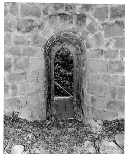
Fig. 165 Montagny-les-Monts / Pré de l'Etang. Etage d'entrée du donjon (K5): l'archère percée sur le côté est et sa chambre
