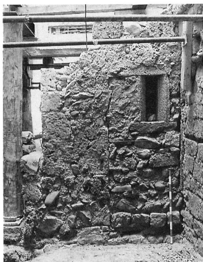
Fig. 120 Fribourg / Grand-Rue 14. Façade primitive de la maison occidentale au premier sous-sol, vue du sud, état du XIV e siècle
