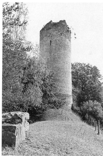
Fig. 162 Montagny-les-Monts / Pré de l'Étang. Vue vers l'est du donjon et d'une portion de rempart
