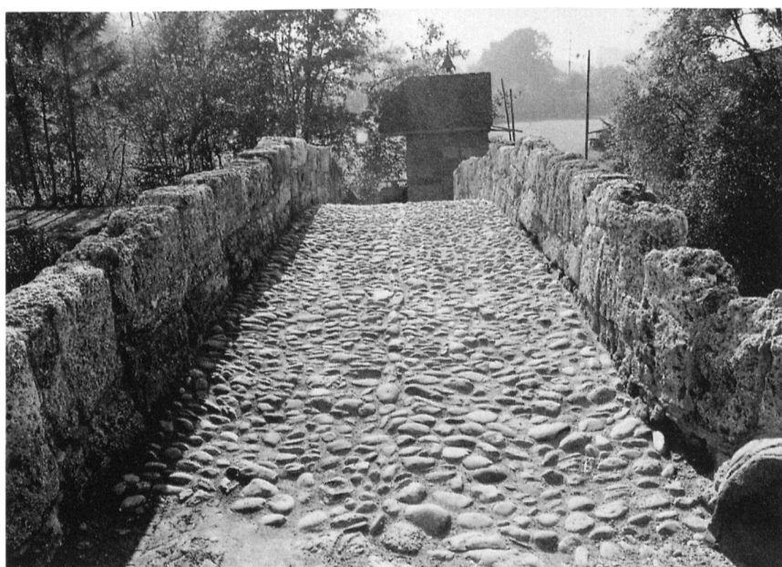
Fig. 236 Villars-sur-Glâne et Posieux / Ste-Apolline. Pavage restitué sur le pont
