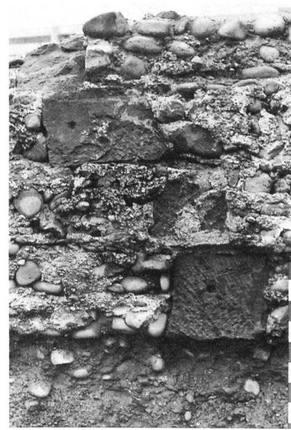
Fig. 152 Fribourg / Cour-Robert. Fondations de l'enceinte du XIV e siècle, détail d'un raccord entre deux étapes de chantier
