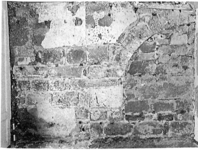
Fig. 106 Fribourg / Samaritaine 9. Rez-de-chaussée, mur mitoyen ouest côté rue; niche et niche de porte de 1326
