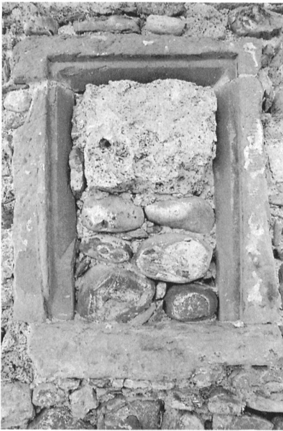
Fig. 240 Villars-sur-Glâne et Posieux / Ste-Apolline. Mur occidental de la chapelle, fenêtre murée
