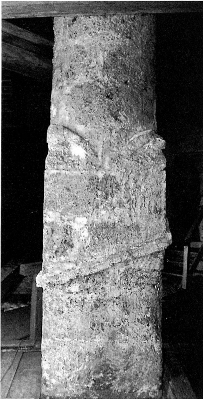
Fig. 22 Bulle / Château. Souche de la cheminée du XIV e siècle. Le cordon de section carrée indique le niveau et la pente du toit d'origine
