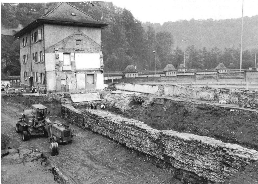
Fig. 151 Fribourg / Cour-Robert. Les fondations de l'enceinte du XIV e siècle (à l'arrière-plan, la piscine de la Motta)
