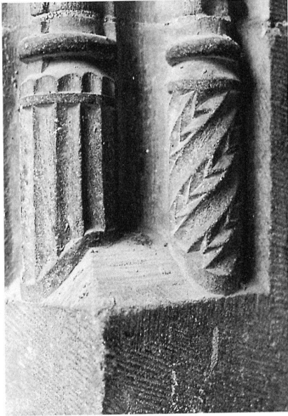
Abb. 169 Murten / Altstadt / Kreuzgasse 4. Fenstergewände von 1528 (Detail)
