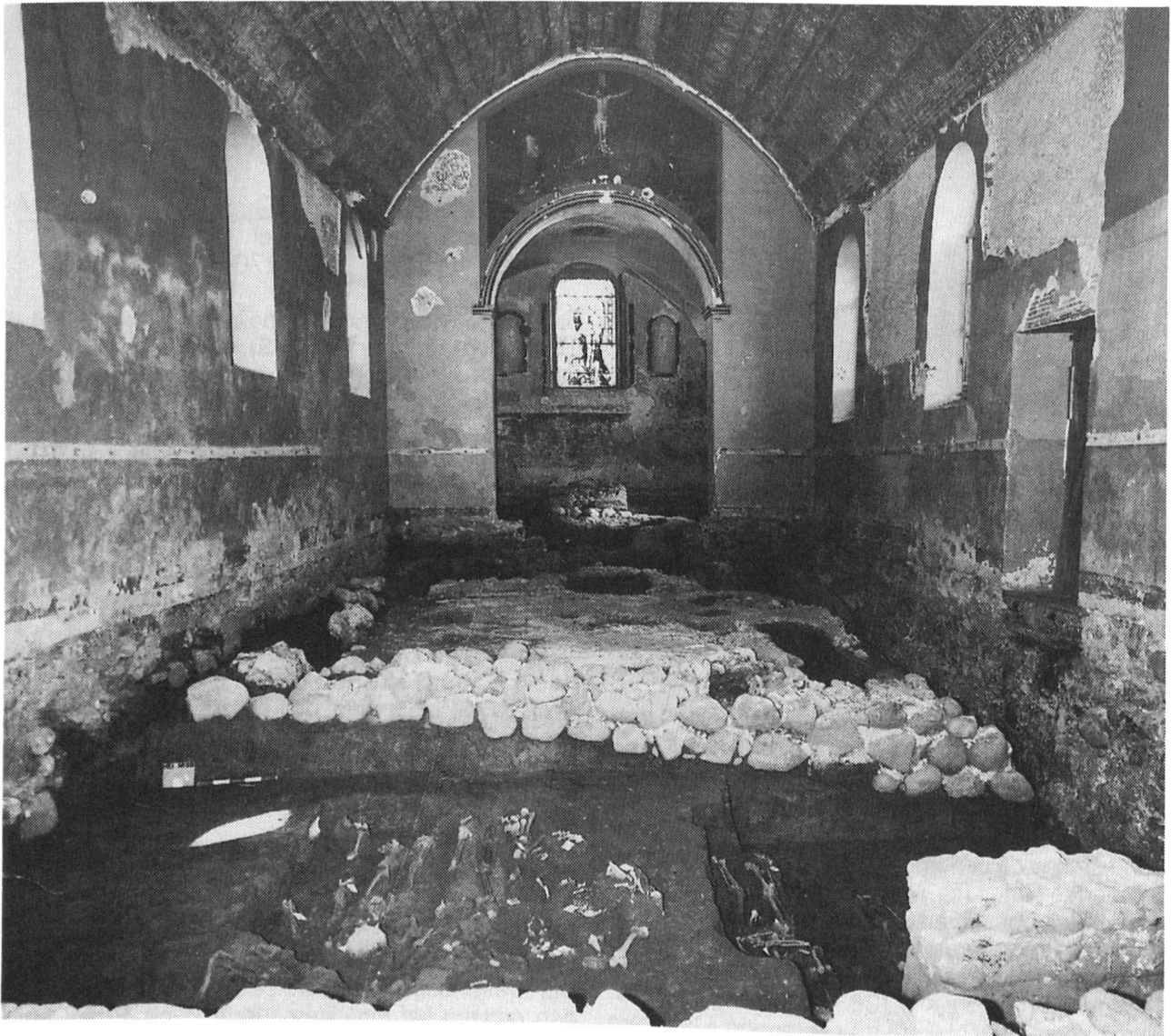
Abb. 91 Heitenried/St. Michael. Die Kirche während der Ausgrabungen. Im Vordergrund die Fundamente der romanischen Fassade
