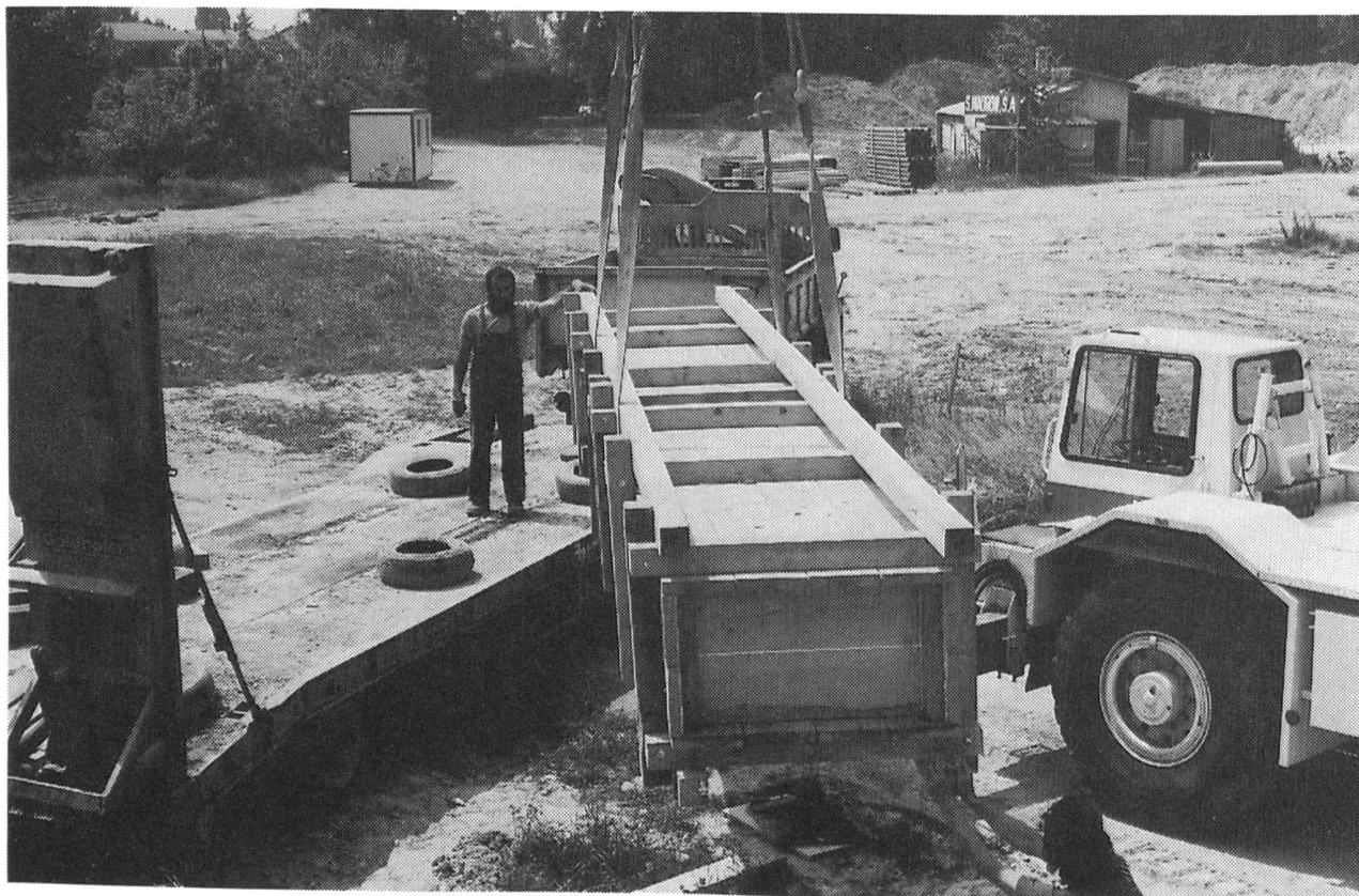
Fig. 37 Estavayer-le-Lac/Sous-Château. Transport de la pirogue par camion grue. La caisse a été construite sur place, sur mesure
