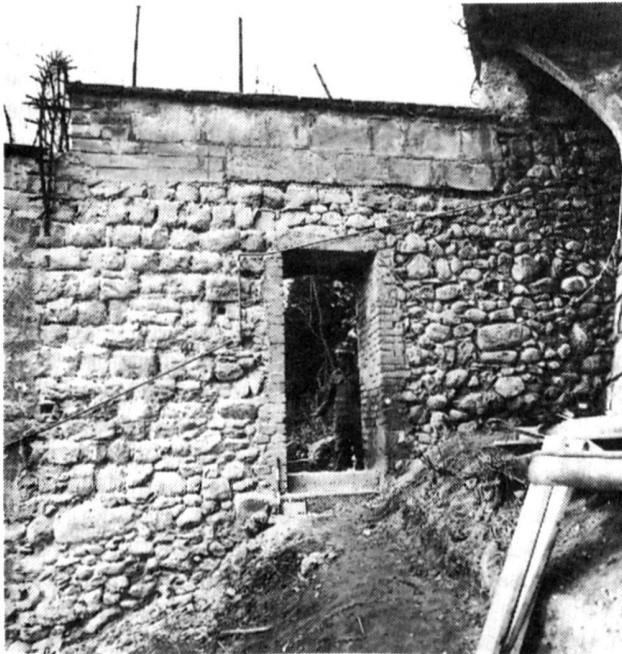
Fig. 48 Fribourg/Parking des Alpes. Enceinte du Grabou parement est
