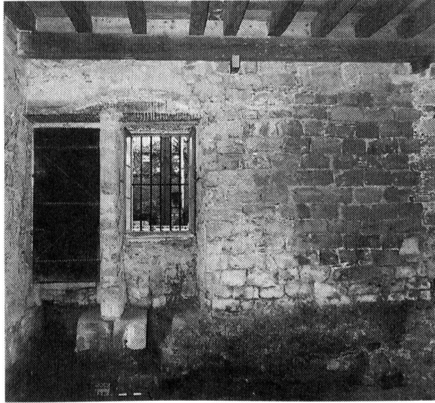
Fig. 154 Romont/Château. Vue partielle de la façade sud de la «salle savoyarde», avec les traces de l'ancienne entrée sous la porte et la fenêtre tardive
