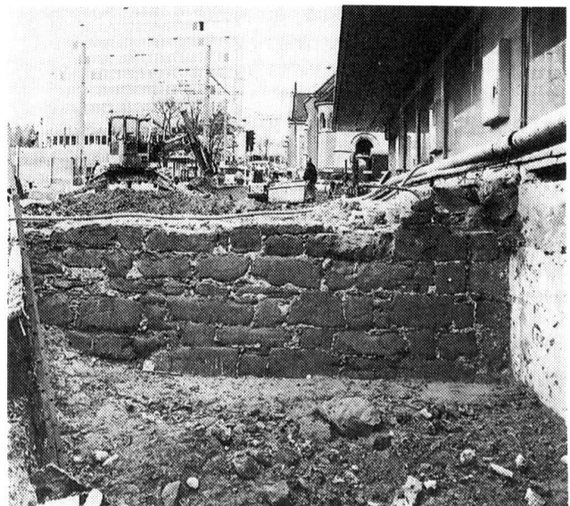
Fig. 43 Fribourg/Tivoli. Mur sud-est, parement extérieur
