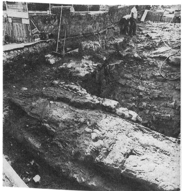
Fig. 76 Fribourg/Pont de Saint-Jean. L'ancienne culée côté Neuveville (second plan: le pont du XVIII e siècle)
