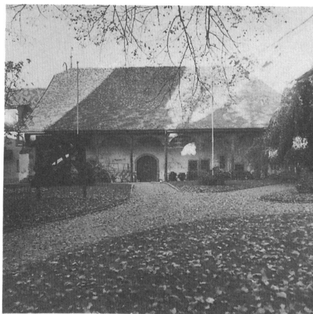
Fig. 148 Romont/Château. Façade sur cour de l'aile nord
