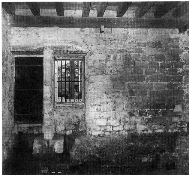
Fig. 154 Romont/Château. Vue partielle de la façade sud de la «salle savoyarde», avec les traces de l'ancienne entrée sous la porte et la fenêtre tardive
