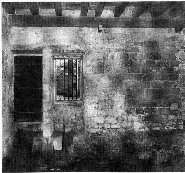
Fig. 154 Romont/Château. Vue partielle de la façade sud de la «salle savoyarde», avec les traces de l'ancienne entrée sous la porte et la fenêtre tardive
