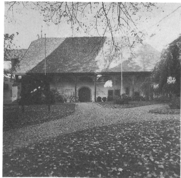
Fig. 148 Romont/Château. Façade sur cour de l'aile nord
