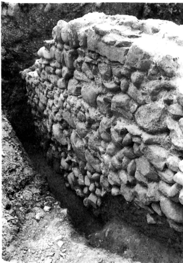
Fig. 49 Fribourg/Parking des Alpes. Enceinte du Grabou parement est, fondations
