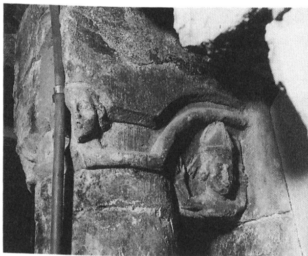
Fig. 22 Bulle/Château. Chapiteau: face ouest
