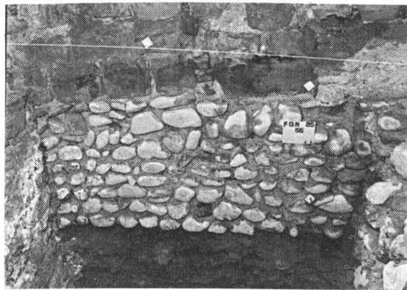
Fig. 20 Grand-Rue 55. L'extrémité nord du mur occidental du bâtiment n° 174.
