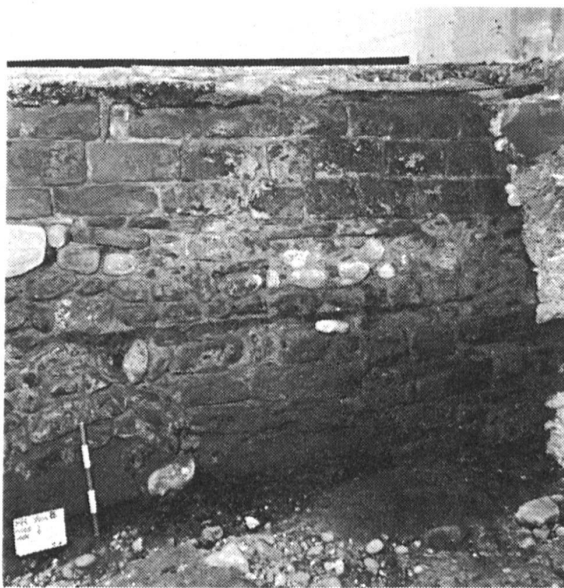
Fig. 9 Rue du Pont-Suspendu 74–75. Le mur oriental du bâtiment n° 232.
