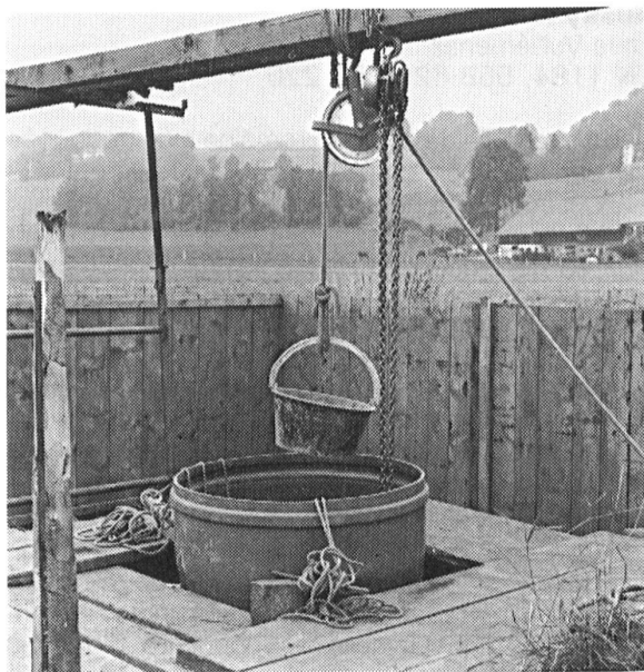
Fig. 79 Marsens/En Barras. Installation de la fouille du puits
