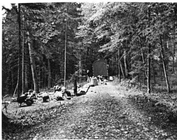
Fig. 54 Posieux/Bois de Châtillon . Vue générale du site
