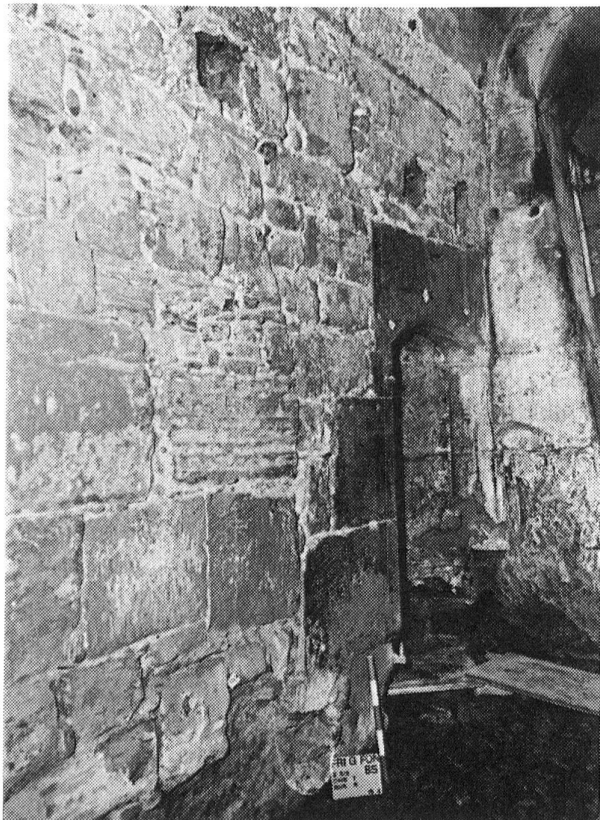
Fig.81 Fribourg, Grand-Fontaine. Porte de l'ancienne façade sud de la maison gothique
