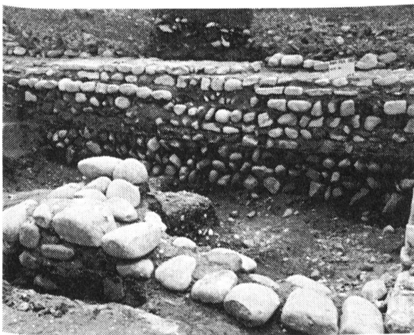
Fig. 52 Marly . Le local 6 ; au premier plan, la tranchée d'aduction d'eau creusée en 1983. On remarque le foyer tardif installé dans le terrazzo.
