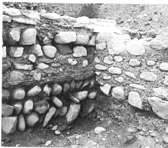
Fig. 35 Marly. Détail des fondations du mur M 24
