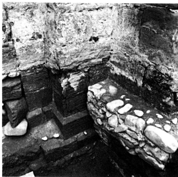
Fig. 13 Photographie de la base du pilier visible dans la façade ouest.
