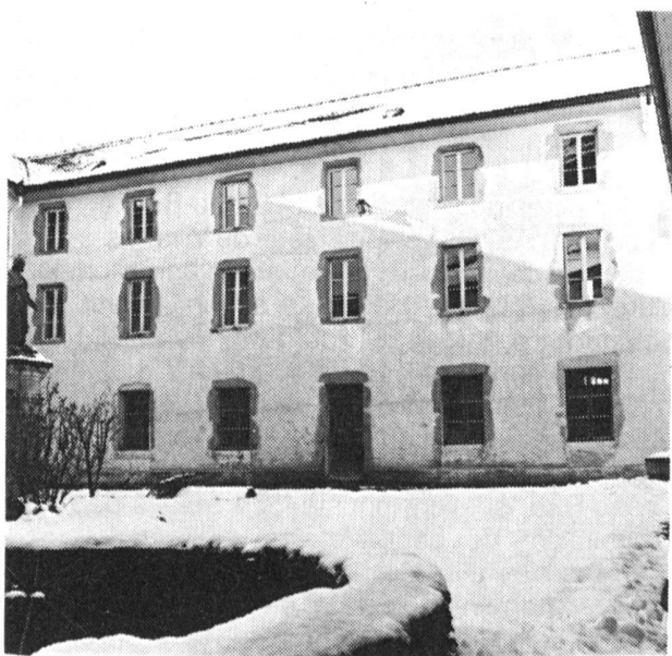
Fig. 53 Estavayer-le-Lac . Façade à l'ouest du cloître
