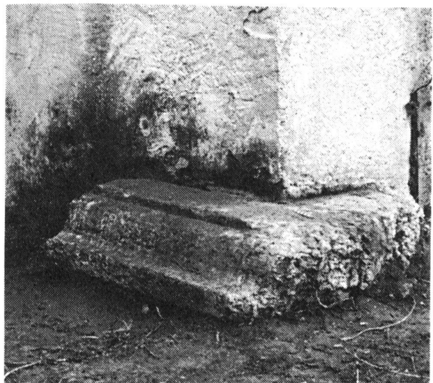
Abb. 76 Kerzers. Eckstein des Fundamentes des Schiffs im Nordosten
