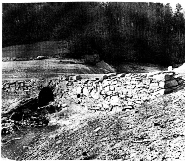
Fig. 38 Avry-devant-Pont . Détail du pont romain
