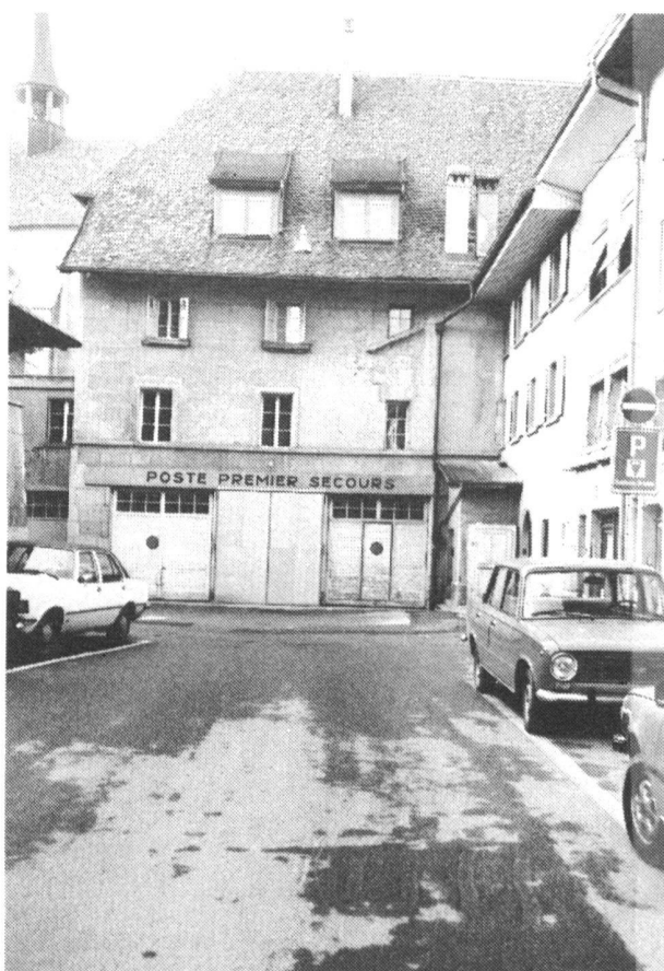
Fig. 94 Fribourg. Ancien grenier. Façade sud
