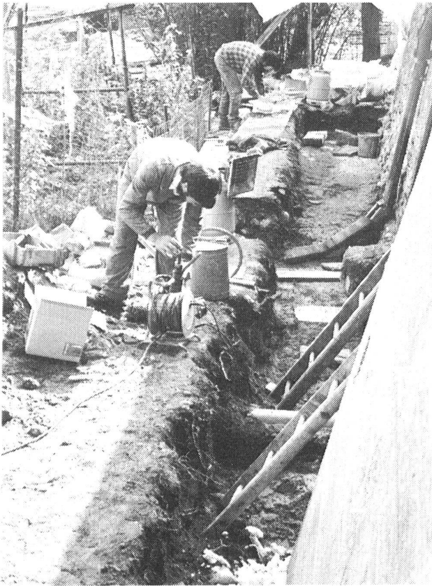
Abb.33 Böisingen. Blick von Westen auf den Grabungsschnitt, nach Abbruch der römischen Mauer. Rechts die Friedhofsmauer.
