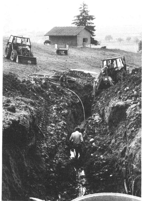
Fig. 50 Cournillens. Vue générale des travaux
