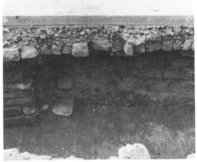
Fig./Abb. 136 (b) locaux II/III, mur 4, à gauche l'angle du mur 6
