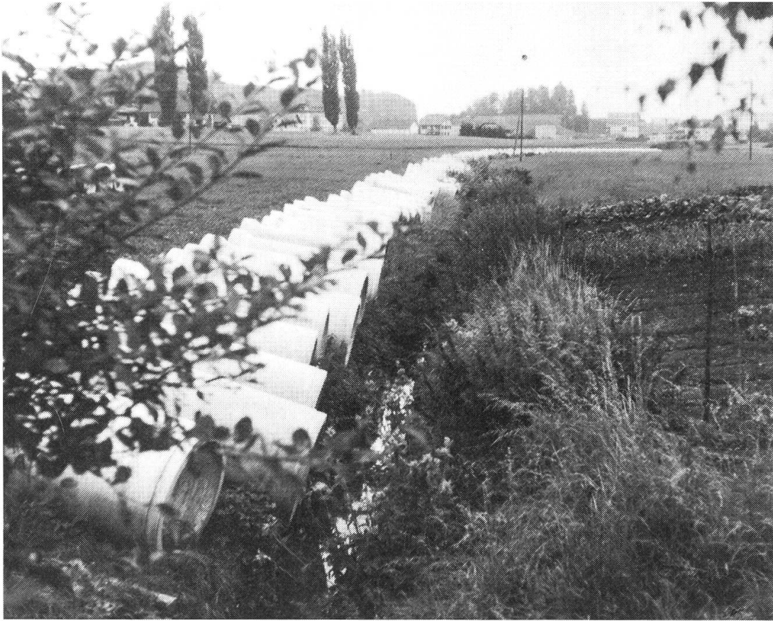
Verlegung von Rohren der ARA Taverna.
