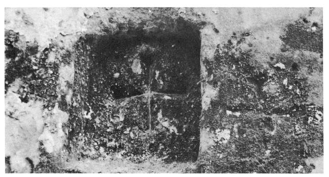
Vermessungskreuz an der Jaccotfluh zwischen dem Unteren Fahr und Oberflamatt südlich der Sensebrücke der Autobahn N 12. Großer Sandsteinblock am Fuße einer Fluh. Rund 180 cm über dem Boden ist in einem 17 cm tiefen Geviert von  $52\times56$  cm ein Kreuz herausgehauen. Die Fluh ist wahrscheinlich nach einem Geometer Jaccot aus Freiburg benannt. Ein Commissar Jaccot wird 1595, 1598 und 1601 in den SMR SAF genannt
