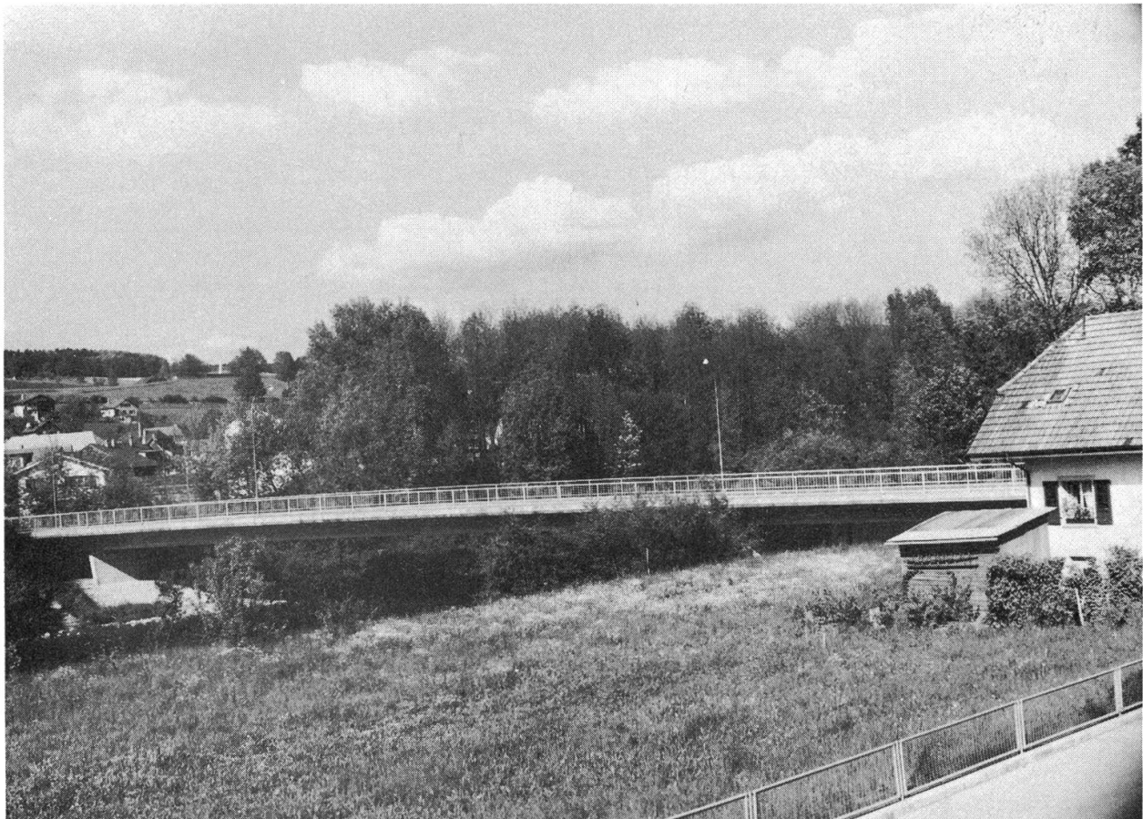
Die neue Straßenbrücke von 1968/69 in Beton zwischen Flamatt und Neueneegg (Foto Jos. Noth, Sensebrück)
