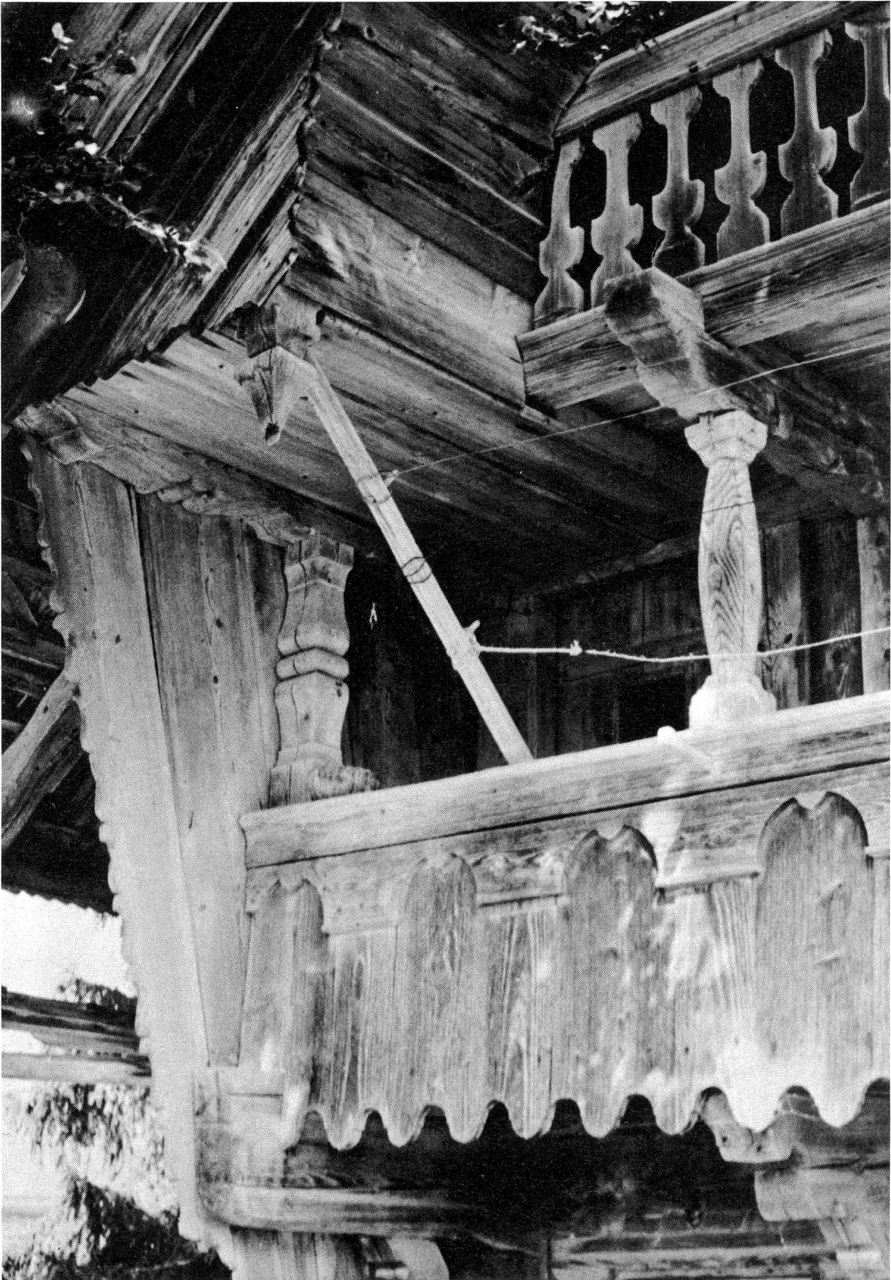
8 SW-Ecke mit Giebelbogen-Ansatz und schräger Wetterwand. Verschieden profilierte Holzsäulen. Untere Laube mit Arkaden-, obere mit Baluster-Täfer (Foto Bauernhausinventar, Freiburg)
