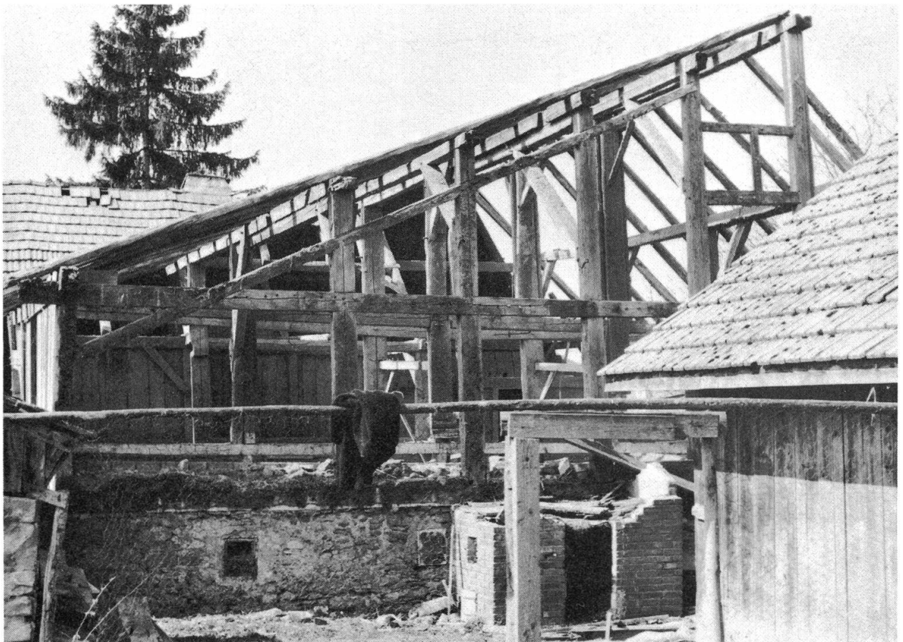
5 Säulenkonstruktion der Scheune, vermutlich 17. Jh., nachträglich erhöht und asymmetrisch erweitert (Foto Bauernhausinventar, Freiburg)
