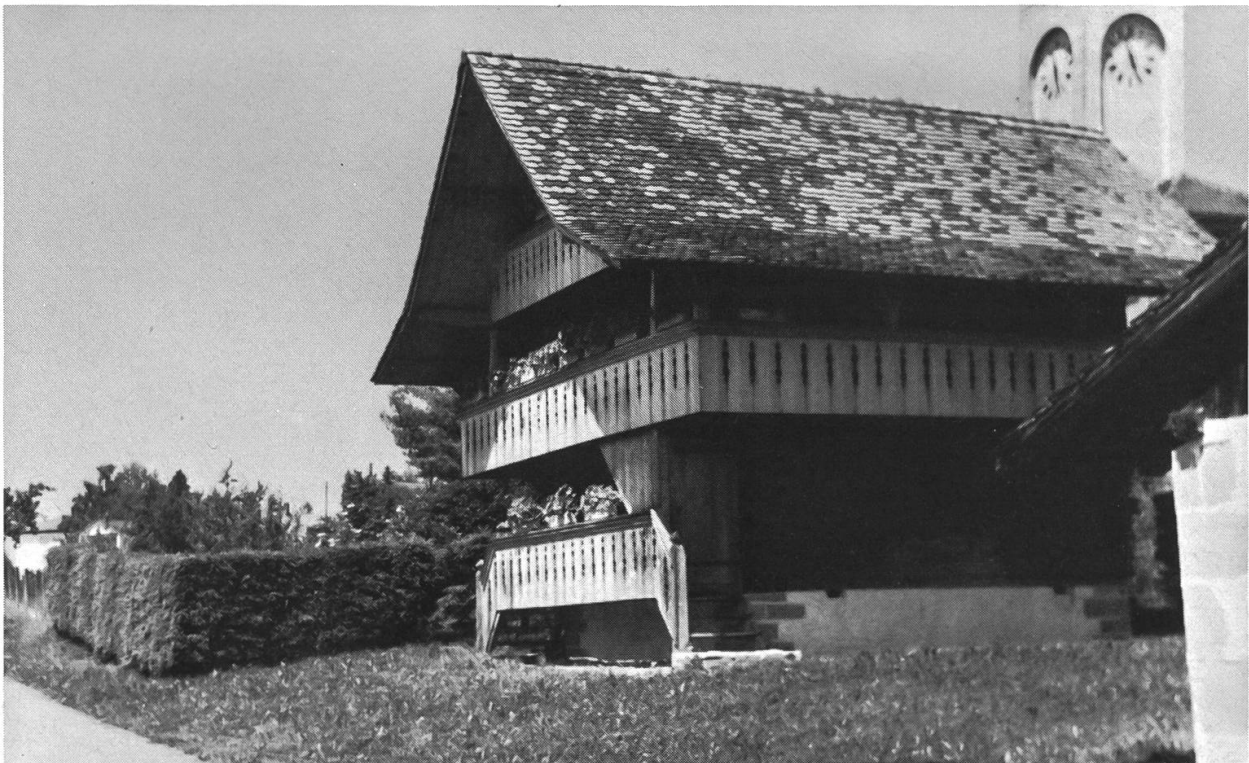
Wünnewil, der Pfarrpfundspeicher von 1733, versetzt und restauriert.
