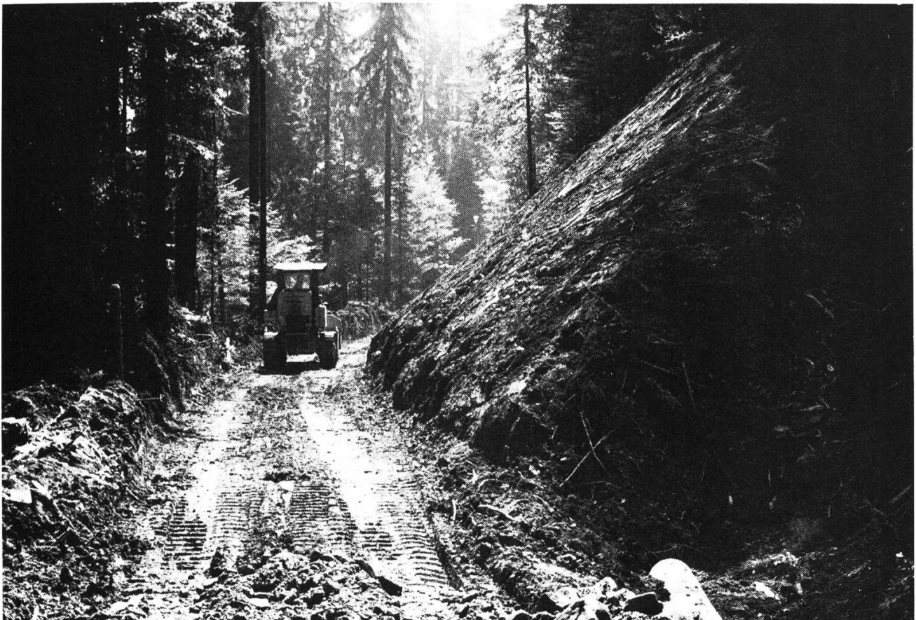
Maschinelles Forststraßenbau in der Gemeinde Plaffeien, 1971 (Photo A. Brühlhart).
