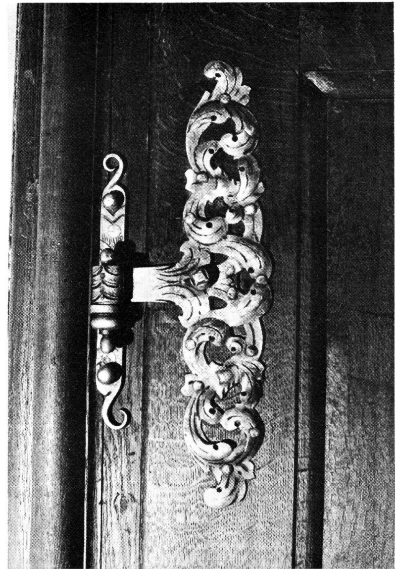
14. Tschüpru, Türangel der Salontüre. Reich verschlungene Laubwerkornamentik, in Eisen getrieben, geschnitten und graviert. Es entsteht der Eindruck von Plastizität im scheinbaren Über- und Untereinanderliegen der einzelnen Blattformen; vorzügliche Arbeit.
