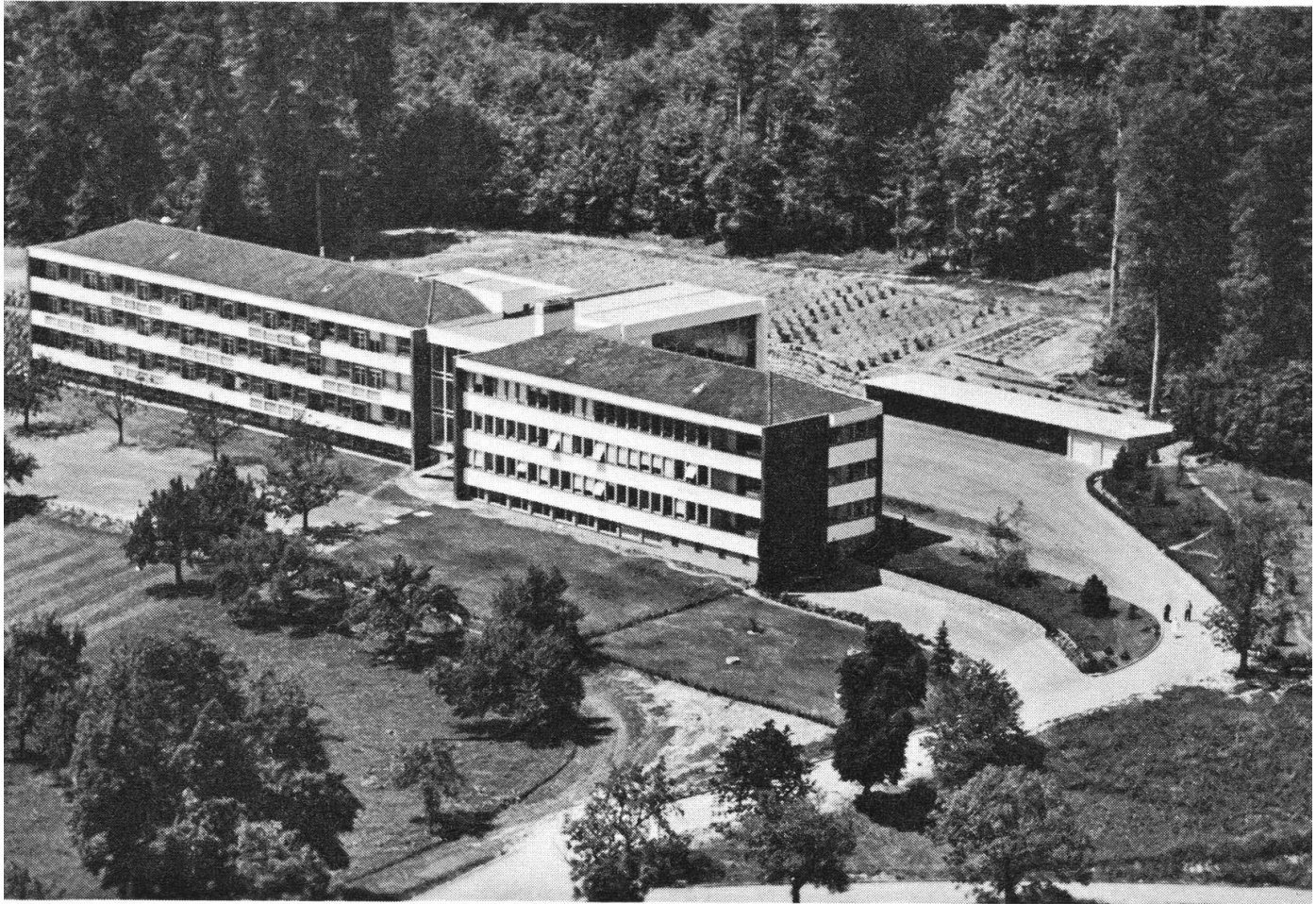
Das neue Spital von Südosten, 1960 bezogen Photo B. Bachmann, Bern
