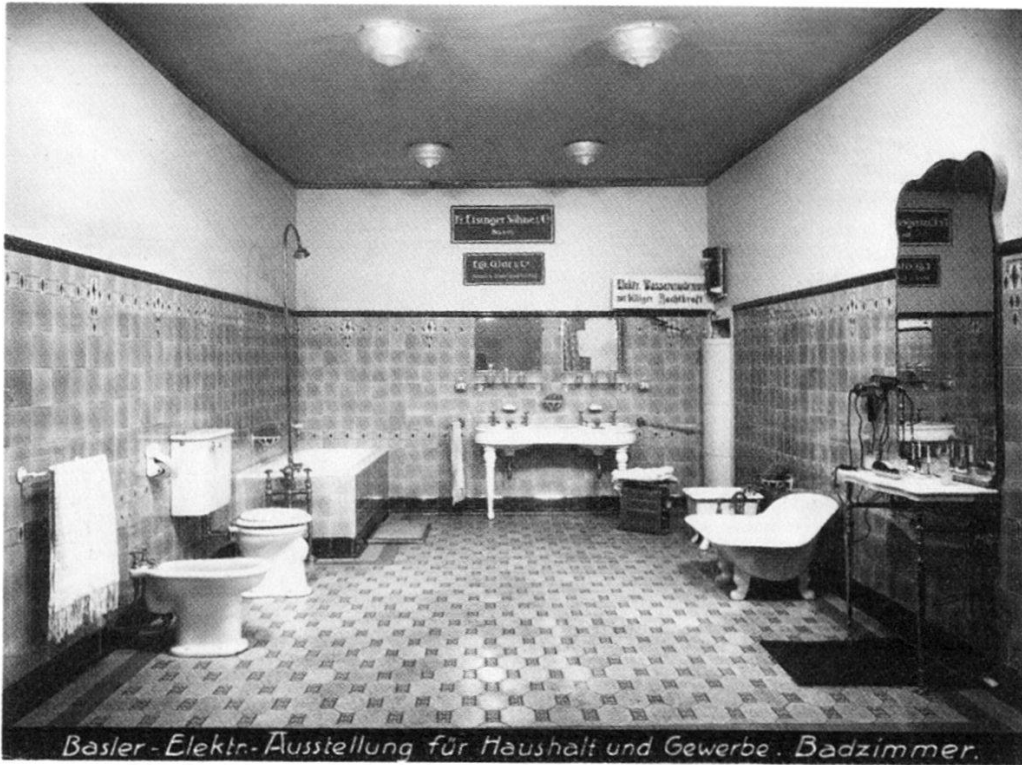
Nr. 7: Das Badzimmer warb vor allem für die elektrische Wassererwärmung mit billiger Nachtkraft.
