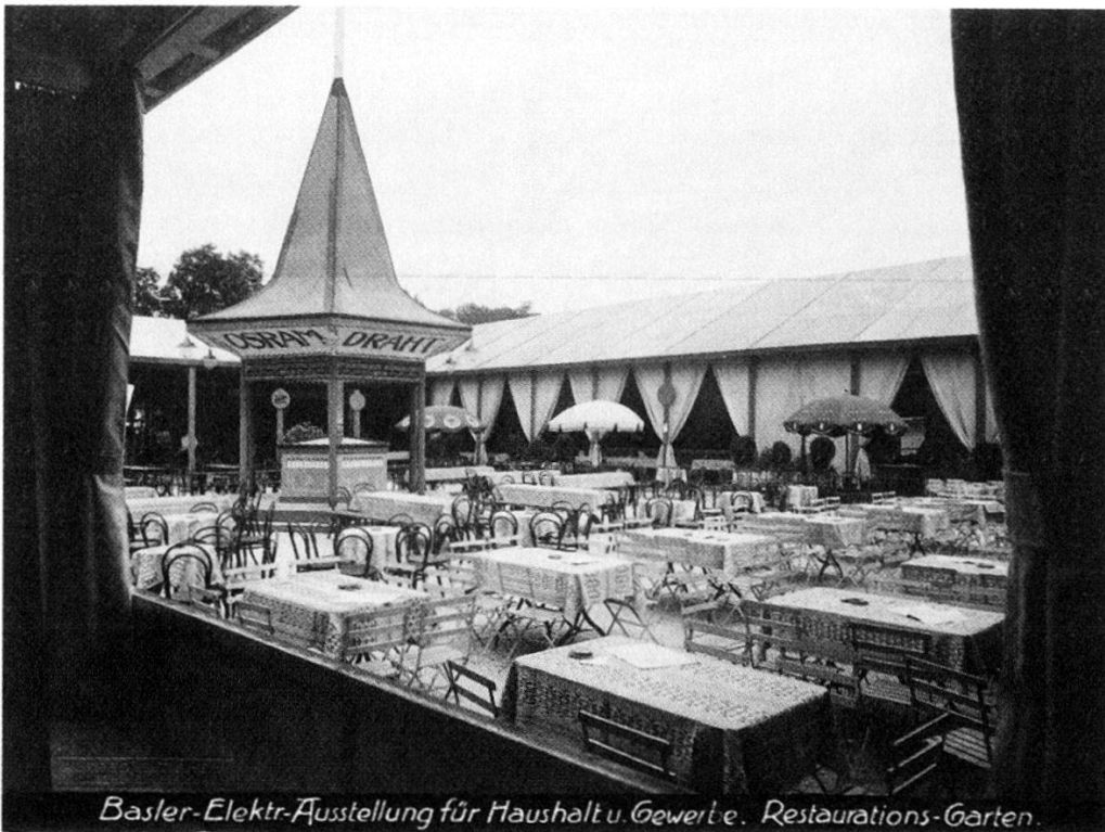
Nr. 12: Der Restaurations-Garten, in der Mitte der Pavillon mit dem Lichtmast, der den gesamten Garten erleuchtete.
