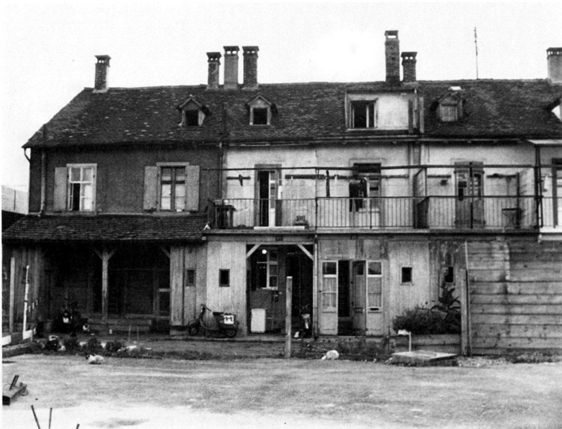
Abb. 2. Basel, In der Breite 15-19, erbaut 1855/56.
