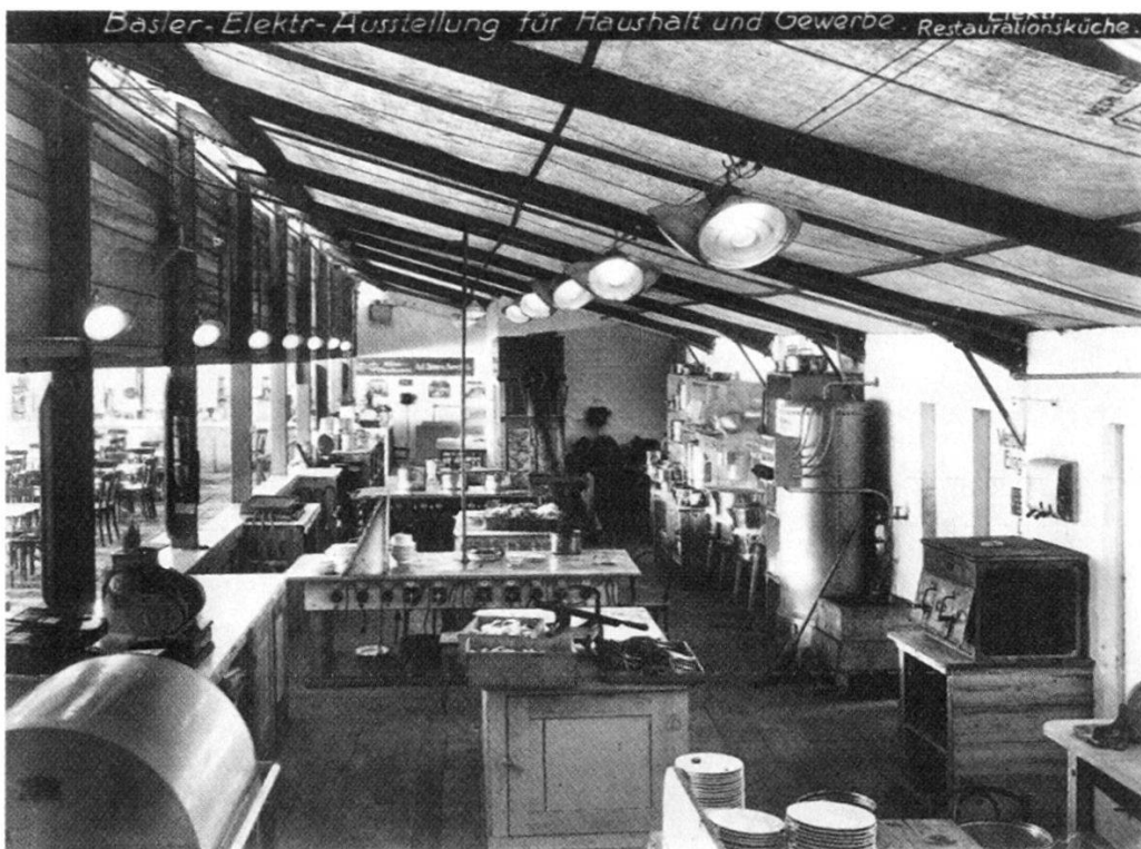
Nr. 14: Der grösste Magnet der Ausstellung war die elektrisch betriebene Restaurationsküche.
