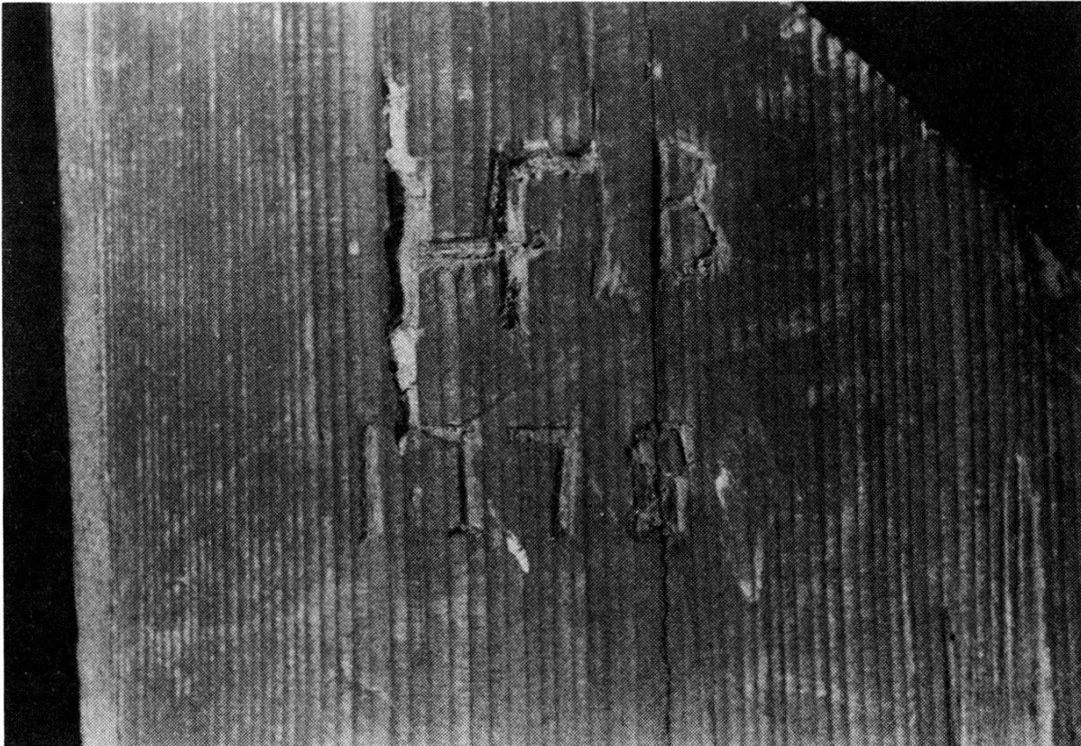
Abb. 12. Von besonderem Interesse ist die in das grobjährige Tannenholz eingeschnittene Signierung und Datierung. Die Zeichen lassen sich als HF B und 1778 lesen. Schwierigkeiten hatte der Handwerker beim Einschneiden der gebogenen Linien, wie beim B und der 8 sichtbar ist.
