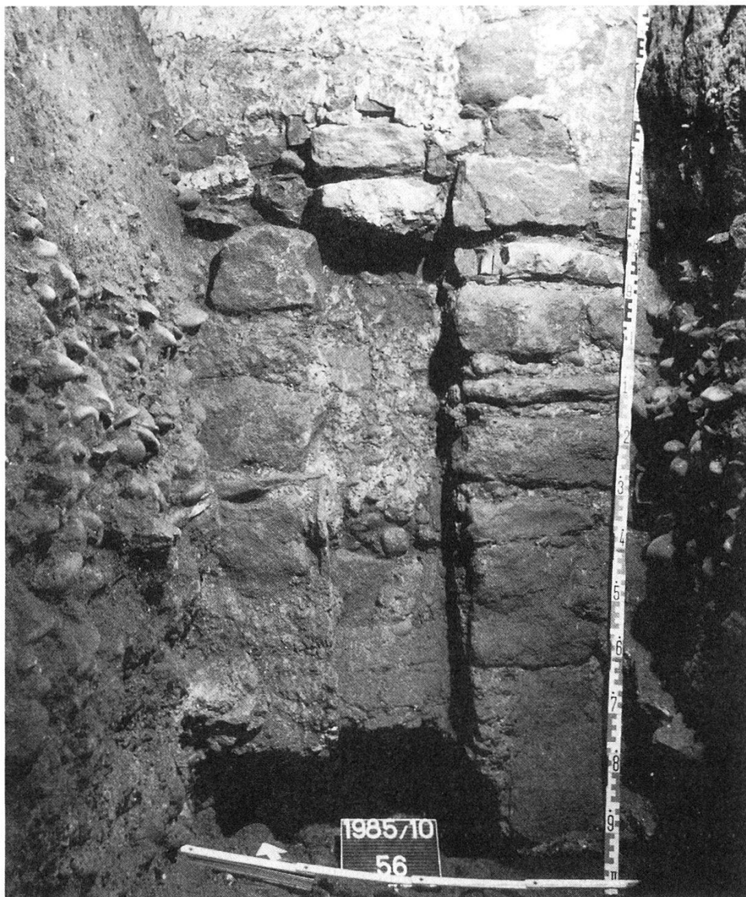
Abb. 52. Leonhardsgraben 47, 1985/10. Unterfangung der Turmfundamente durch die Innere Stadtmauer.
