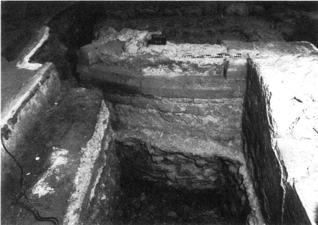
35c. Aussenansicht der Chorpartie mit Fundamentzone, Sockel und Säulenbasis. Links Reste des Mörtelbodens in der Sakristei, rechts Reste des Aussenputzes am aufgehenden Mauerwerk des Langhauses.
