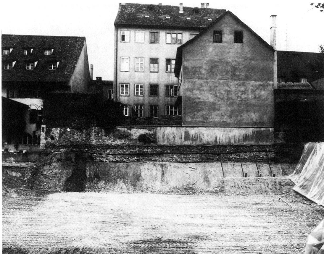
Abb. 7. St. Alban-Tal 40A, 1986/26. Ansicht Mauer MR 1 im Norden der Baugrube.
