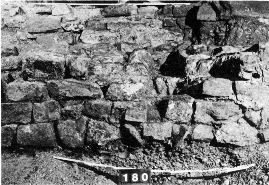
Abb. 45. Schneidergasse 2, 1982/3. Phase 1: Böschungsmauer aus weitgehend trocken versetzten Quadern (Abb. 44, A). Im Hintergrund ist die jüngere Stützmauer sichtbar. Blick gegen Westen. (Abb. 44, G).
