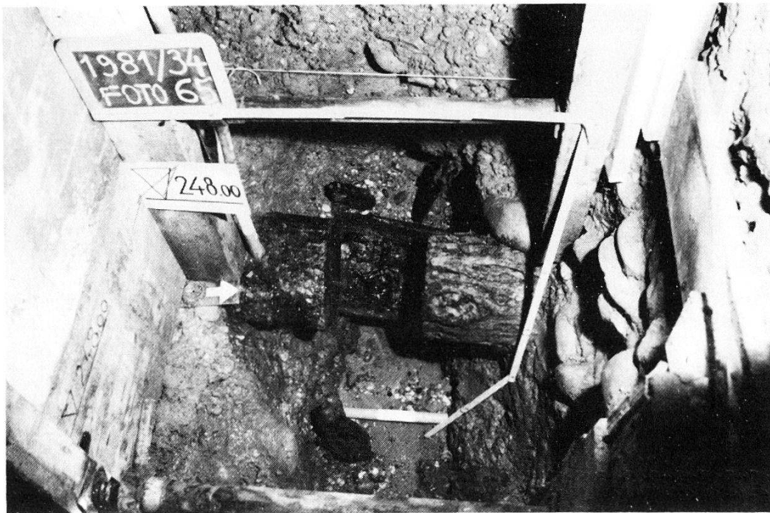
Abb. 73. Stadthausgasse 20, 1981/34. Holzbalken der Uferverbauung am Birsig.
