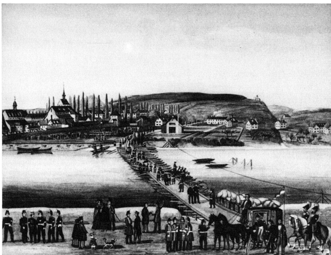
Abb. 49. Schiffsbrücke beim Theodorsgraben, wenig unterhalb des vermuteten Rheinübergangs am Burgweg. Errichtet 1857 unter General H. Dufour. – Foto: Staatsarchiv Basel.
