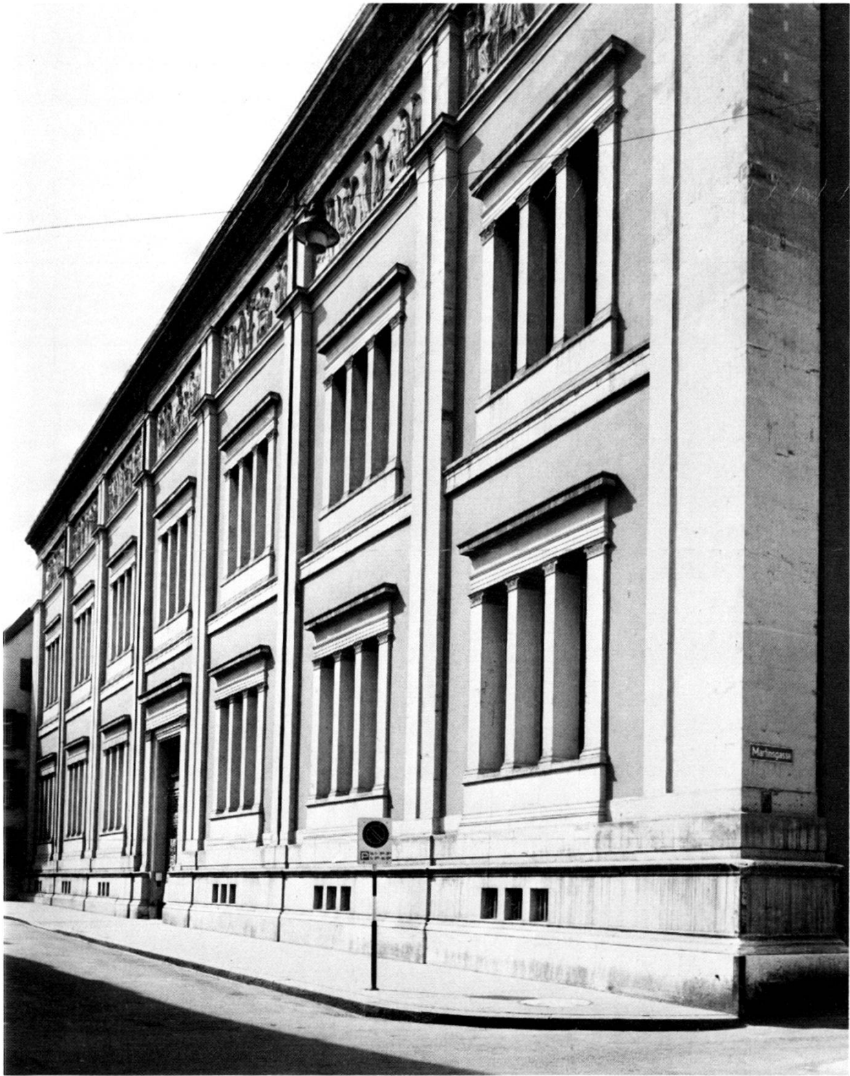
Abb. 9. Die Fassade von Nordwesten ( Aufnahme 1969).
