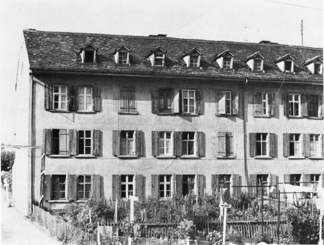
Abb. 3. Basel, In der Breite 9-13, erbaut 1856/57.
