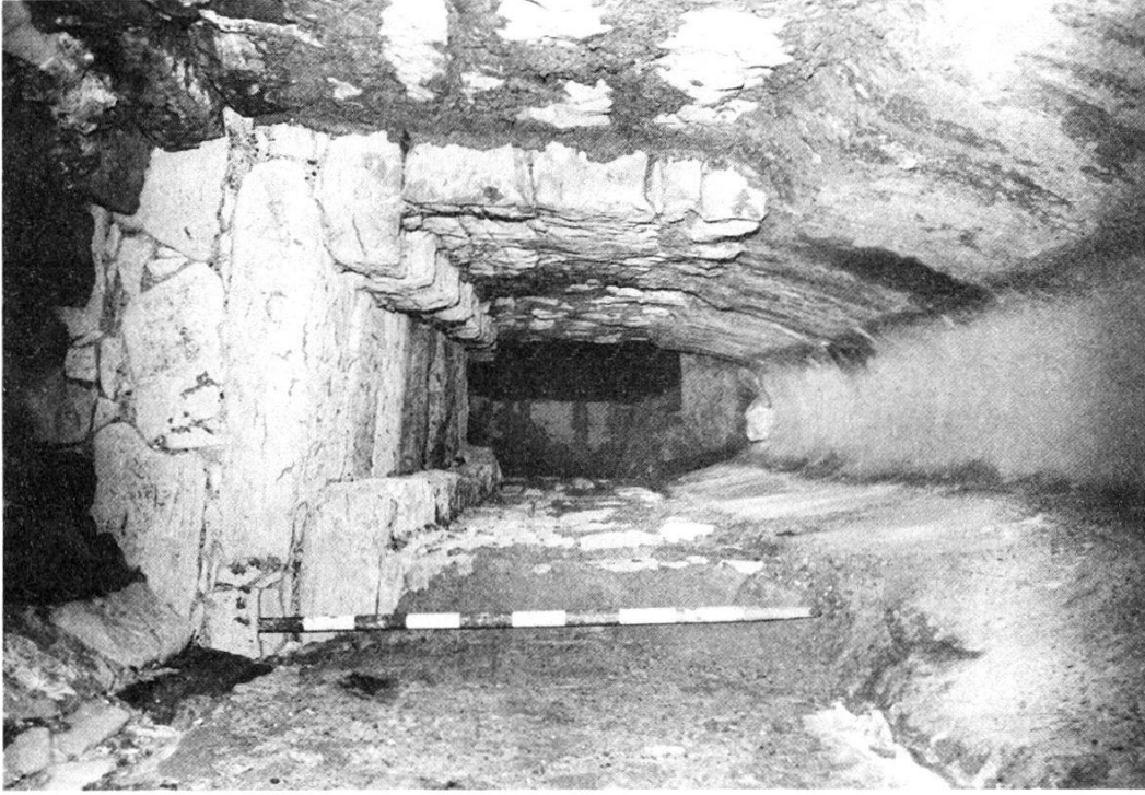
Tafel 1. Petersgraben 31: Abwasserleitung im alten Stadtgraben unmittelbar vor der romanischen Stadtmauer liegend.
