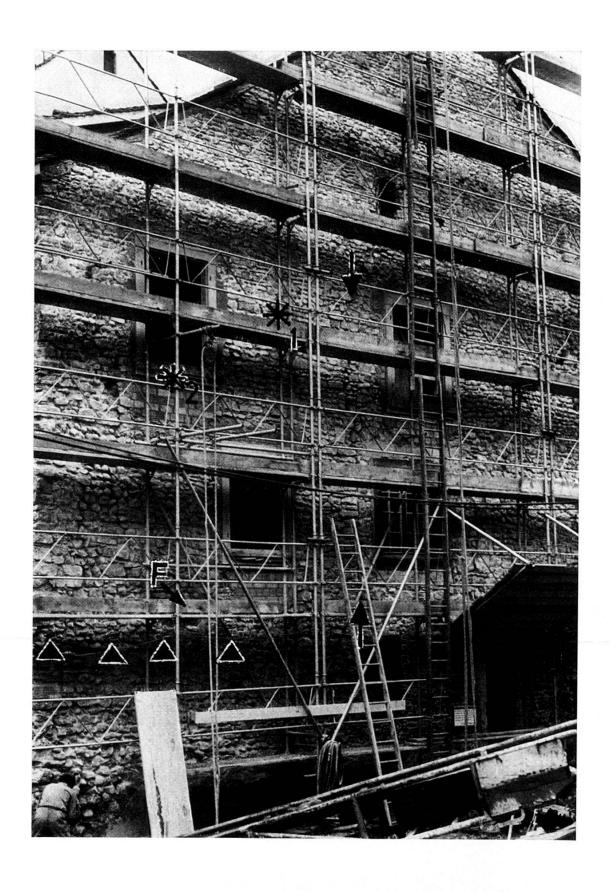
Tafel 11. Rittergasse 16: Ansicht der Südfassade. – Pfeile markieren die Baufuge zwischen dem frühgotischen Hauskern links und den spätgotischen Anbauten rechts. F=altes vermauertes Fensterlein. \*1=Stelle des eingemauerten frühgotischen Kugeltöpfchens (Abb. 25); \*2=Fundstelle der hochgotischen Töpfe (Abb. 27). Über den Dreiecklein die vermauerten Pfostenlöcher.
