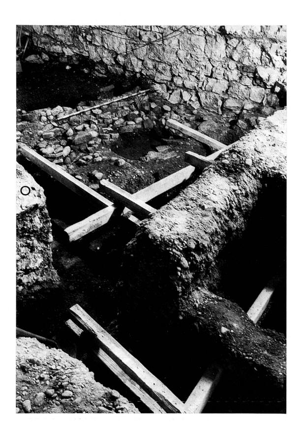
Tafel 8. Rittergasse 5: Einblick von hinten in die Konstruktion des Murus Gallicus, Balkenlager durch eingesteckte Kanthölzer markiert. Beim Jalon die verstützten Steine der Frontmauer (F), in die die Balken einbanden. – Links Fundamentreste der abgetragenen Südmauer der Ulrichskirche (O).
