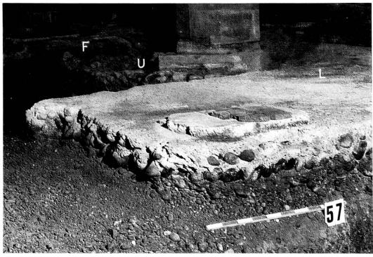
Tafel 12 oben. Standort des hochgotischen Pfeilers U: Blick vom Mittelschiff gegen Nordost auf den mittleren Pfeiler, der auf dem nördlichen romanischen Fundamentriegel steht. Davor beim Maßstab im Mörtel der Abdruck der Basisplatte des hochgotischen Pfeilers U.
