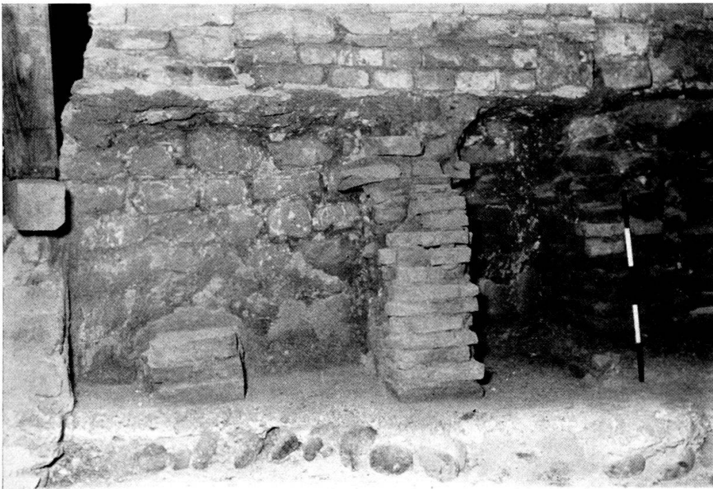
Taf. 1, 2. Nordwand des Hypokausten mit aufgesetzter mittelalterlicher Mauer. (Aufnahmen des Verfassers.)
