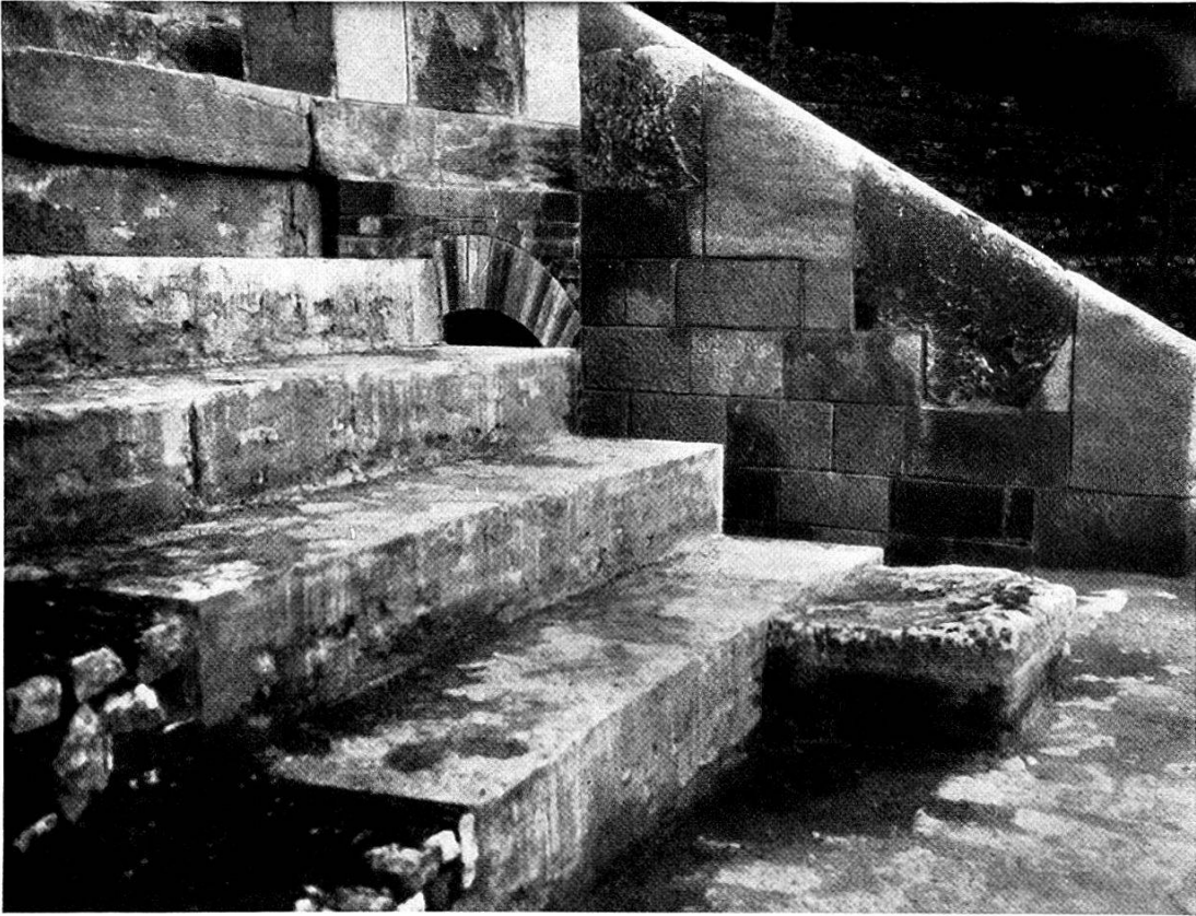
Taf. IVa. Nordausgang des Süd vomitoriums, nach der Rekonstruktion im Sommer 1941. Vorne rechts Quader der ersten Sitzstufen, links gemauerte Unterlagen, hinten erneuerte Brüstung mit Originalstein (vgl. Abb. 3).
