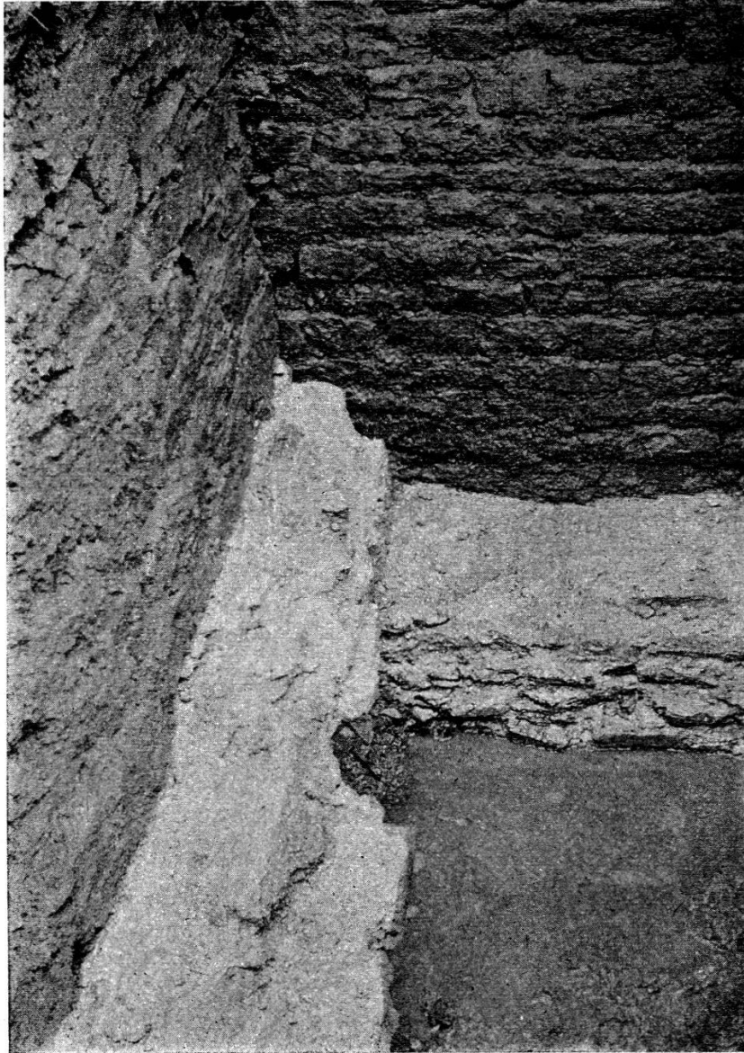
Textabbildung 3: Rechts: Mauer S 3 der Periode III c; links: Mauer V der Periode III e (S. a. Tafel I).
