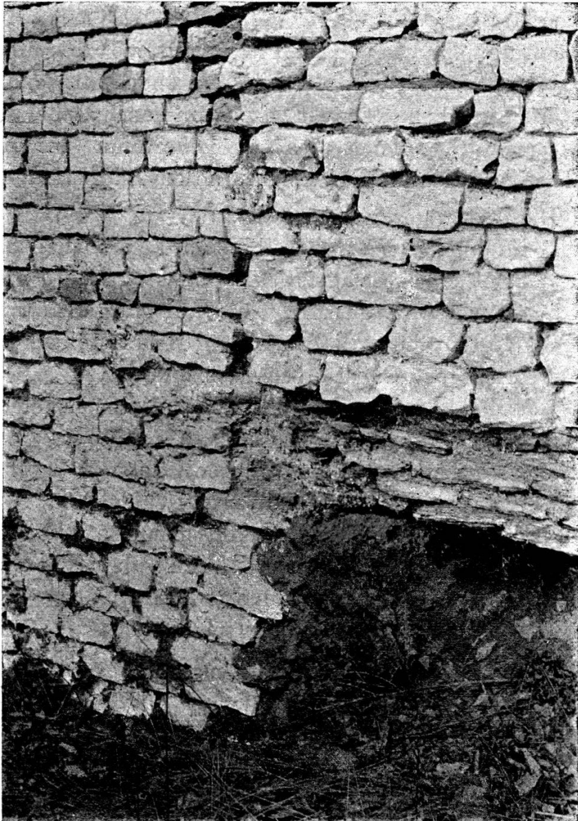
Textabbildung 4: Verbindungsstelle der Mauern W 1 (rechts) und W 3 (links) der Perioden III b und III d (S. Tafel I).
