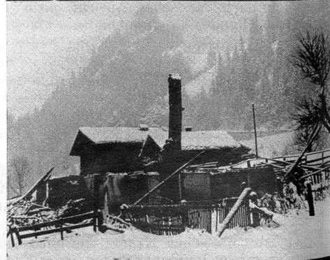
Das Haus der Frau Hari in Mitholz ist vollständig ausgebrannt. Im Hintergrund oben die Ruine Felsenburg, die von der Lötschbergbahn umfahren wird
