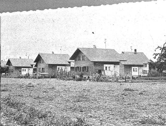
Neue Wohnsiedlung in Oberdorf
