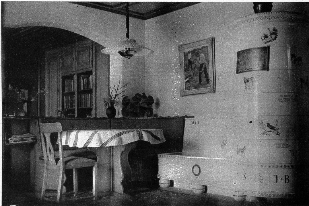
Oben: Ein neuer Kachelofen, erstellt 1944, mit handbemalten Kacheln, der sich dem Wohnstil wirkungsvoll anpasst. Unten: Die Teilung des Raumes durch einen Holzpfiler erforderte einen doppelseitigen Ofen: links als Cheminée und rechts als Ofenanlage
