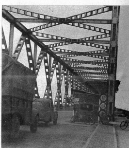
Da diese Strassenbrücke über den holländischen Diep noch in Reparatur ist, wird der sehr strenge Verkehr einseitig abwechselnd geführt. Oft muss man eine Viertelstunde warten
