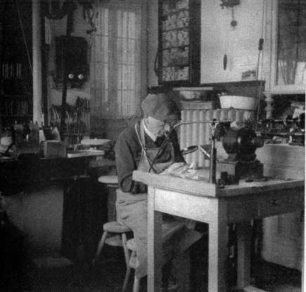
Ob für den Lohn unvorstellbar feine Details müssen aus dem Elfenbein herausgearbeitet werden, was mittels einer vielfach vergrösserten Lupe und feinsten Stahlwerkzeugen geschieht!
