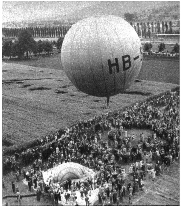
Im Rahmen des Internationalen Kongresses der Ballonfahrer fand als Abschluss ein Aufstieg zweier Freiballone vom Gaswerk Schlieren bei Zürich statt.
