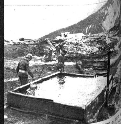
Das Walser Dörflein Obermatten, 1876 in der Mutehorn (Grbd.) gelegen, wurde das Dorf durch die furchtbare Brandkatastrophe. Nahezu alle der 37 Gebäude brannten bis auf den Grund ab. Die Löscharbeiten mussten sämtliche einzigen Brunnen aus bewältigt werden.
