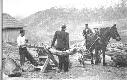
Der Bauplatz, wo das Holz aus den umliegenden Wäldern zersägt und gehobelt wird. Rechts ein typischer Bündner Karren, wie sie dort gebräuchlich sind.
