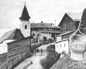
Die Kirche von Trans, die von der grossen Feuersbrunst verschont geblieben war. Daneben eines der ebenfalls erhaltenen Wohnhäuser und im Vordergrund drei behelfsmässige Not-hütten für Heu und Werkzeuge. Rechts: Der Gemeindepräsident geht zum Brunnen, um Wasser für das Haus oder den Stall zu holen. Er ist zufrieden, dass das Dorf wiedererstanden wird, und dass er nachher das Wasser im eigenen Haus haben wird.
