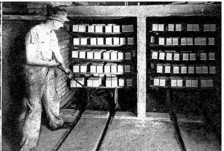
Die Backsteine werden aus der Trocknerei ausgefahren
