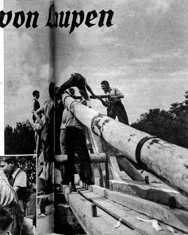
Oben: Die „Rute“ wird an den beiden Seitenklammern befestigt. Auch das muss natürlich von geübten Fachleuten geschehen. Die Schüler verfolgen das Werk mit grossem Interesse
