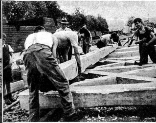
Balken um Balken wird sorgfältig ineinandergefügt, damit der Unterbau die schwere Last trägt
